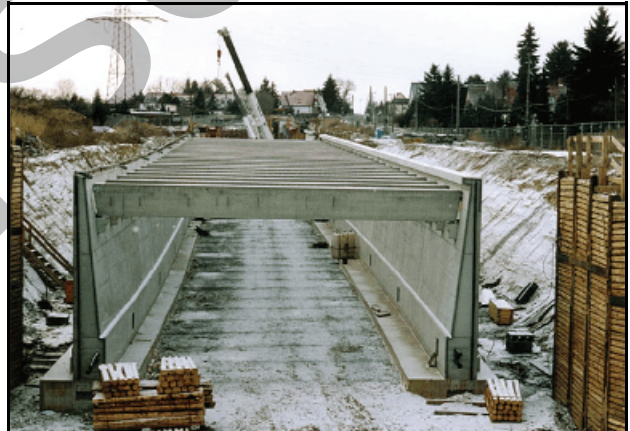
Abb. 2.1.74: Bau des Lärmschutztunnels Nickern an der Anschlussstelle Prohlis 2003.
