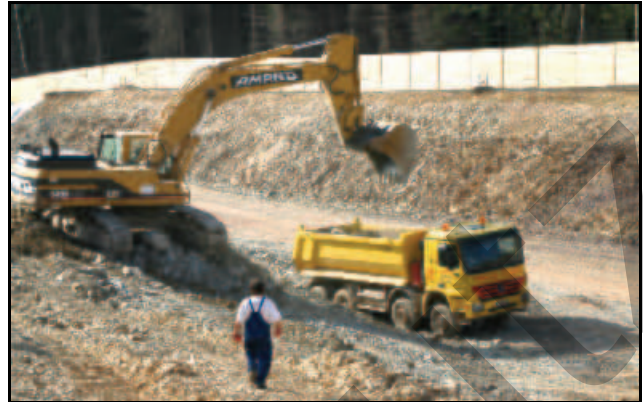
Abb. 2.1.88: Baggerarbeiten quer zur Straße S174 im Jahre 2004.
