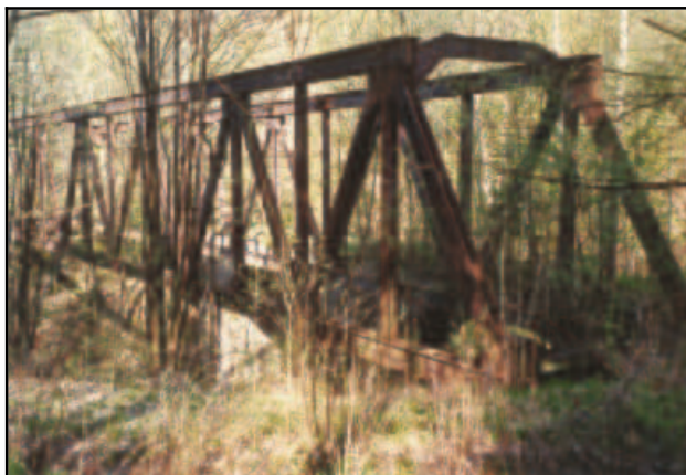
Abb. 2.2.61: Die stählerne Eisenbahnbrücke oberhalb des Bahnhofes von 1928 im Jahr 2004. Hinter dieser Brücke steht die alte Steinbrücke von 1880.
