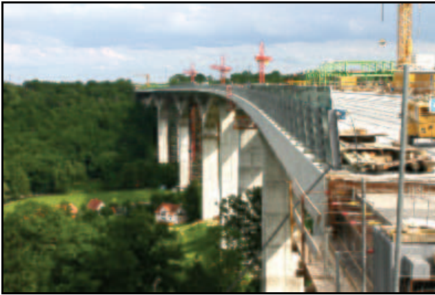
Abb. 2.1.77: Die Lockwitztalbrücke im Bau 2005.
