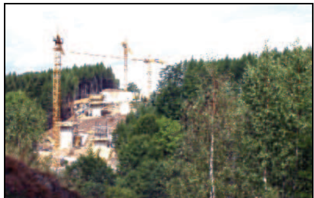
Abb. 2.1.92: Beginn des Baus der Brückenpfeiler.
