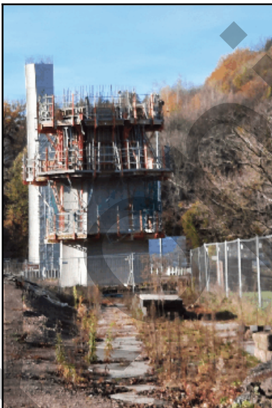
Abb. 2.1.139: Bau eines Pfeilers für die Gottleubatalbrücke 2020.
