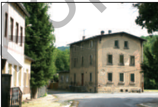
Abb. 2.2.41: Bahnhofsgebäude Bad Gottleuba 2008
