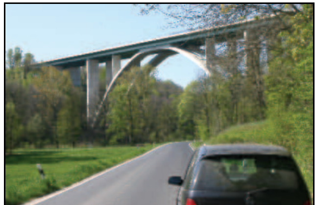
Abb. 2.1.86: Die fertige Brücke 2006.
