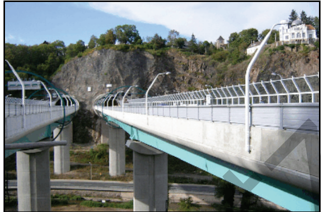
Abb. 2.1.72: Die Tunnel-Brücke-Tunnel-Konstruktion am Plauenschen Grund 2004.
