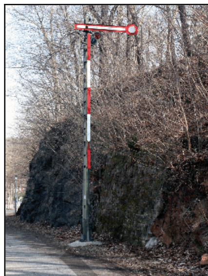
Abb. 2.2.50: Das Einfahrtssignal in den Bahnhof Berggießhübel 2011.
