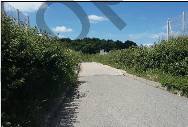
Abb. 2.1.126: Die Brücke für den Wirtschaftsweg von Laurich nach Friedrichswalde über die A17.
