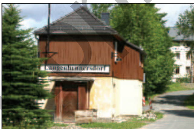
Abb. 2.2.65: Das von Langenhennersdorfer Eisenbahnfreunden rekonstruierte Gebäude des Bahnhofes.
