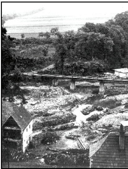
Abb. 2.2.30: Die Eisenbahnbrücke oberhalb von Berggießhübel nach dem Hochwasser 1927.
