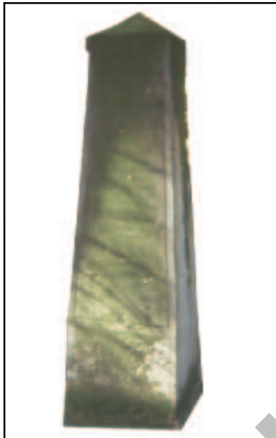
Abb. 2.3.44: Zustand des Steines 1975. Foto: Hering
