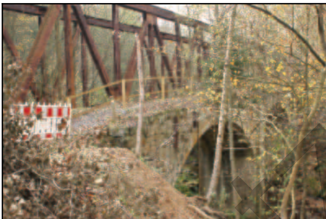
Abb. 2.2.62: Die steinerne Eisenbahnbrücke von 1880 im Jahre 2002.
