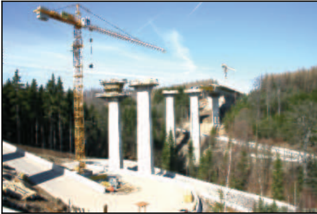
Abb. 2.1.93: Die Brücke wird 2005 über die Pfeiler geschoben. Zu erkennen ist das System der Baustraßen an den steilen Hängen des Tales.
