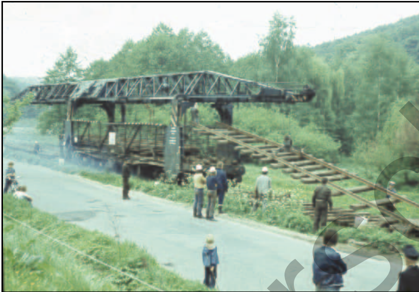
Abb. 2.2.39: Rückbau der Gleise zwischen Bad Gottleuba und Berggießhübel 1976. Foto: Samml. Mörbitz, Berggießhübel
