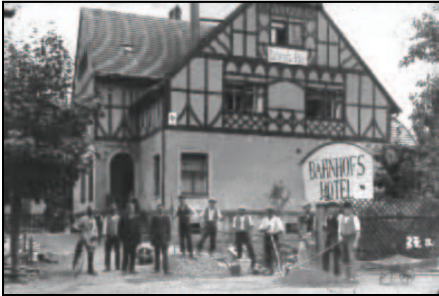
Abb. 2.2.28: Das Bahnhof Hotel Gottleuba und jetziges Bürgerhaus nach dem Hochwasser 1927. Nach 1945 wurde das Schützenhaus Bahnhof Hotel.
