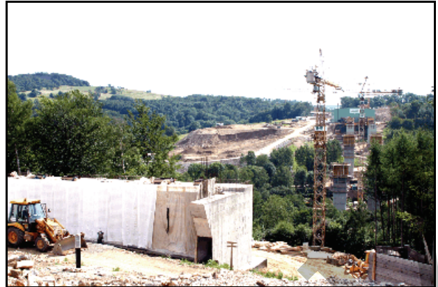
Abb. 2.1.100: Blick von der Harthe in Richtung Sattelberg 2005 mit der entstehenden Grenzbrücke.
