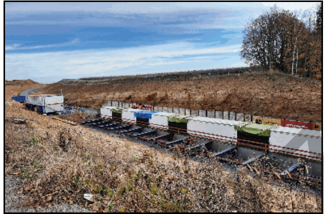
Abb. 2.1.141: Die Montage der Fahrbahn auf der Baustelle über der Viehleite 2020.
