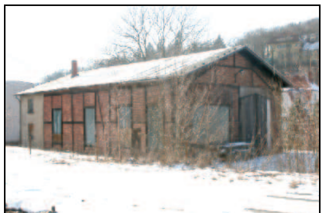
Abb. 2.2.42: Der von dem Bahnhof Berggießhübel 1905 umgesetzte Lockschuppen im Jahre 2012.
