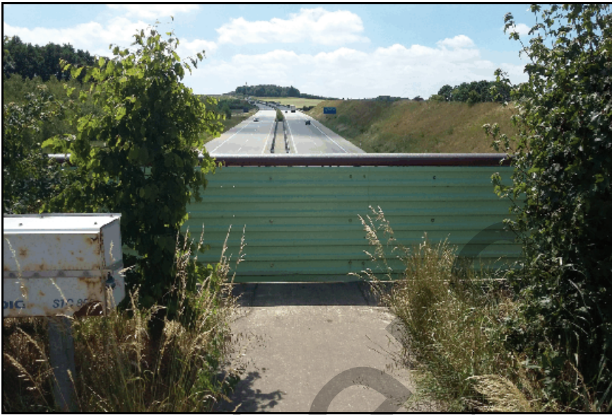
Abb. 2.1.130: Links der Sensor für die Erfassung der Fledermäuse auf der Brücke.
