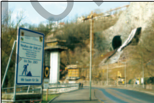
Abb. 2.1.69: Bau der Weißeritztalbrücke im Plauenschen Grund 2001.
