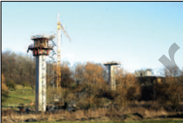
Abb. 2.1.116: Bau der Pfeiler der Brücke über das Bahretal 2007.
