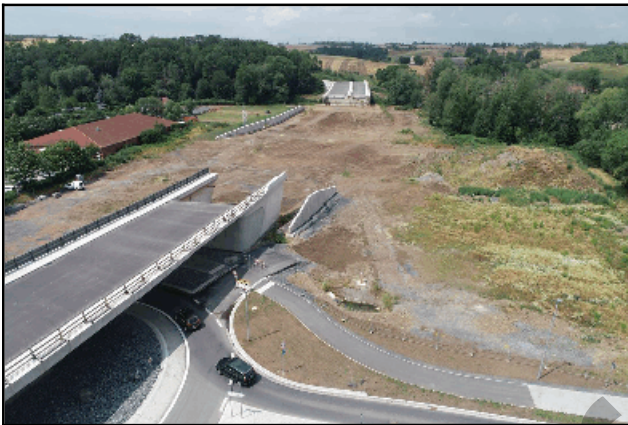
Abb. 2.1.137: Links die Seidewitztalbrücke über dem Kreisverkehr. Im Hintergrund die Seidewitzbachbrücke 2020.
