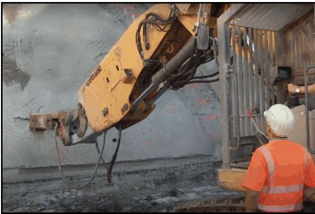
Abb. 2.1.143: Der feierliche Anstich für den Kohlberg-tunnel am 9. September 2020.
