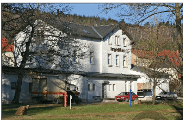
Abb. 2.2.51: Der ehemalige Bahnhof Berggießhübel 2002.
