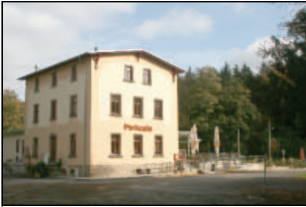
Abb. 2.2.43: Das ehemalige Bahnhofsgebäude Bad Gottleuba nach dem Umbau durch die Familie Helm zum Parkcafé 2014.
