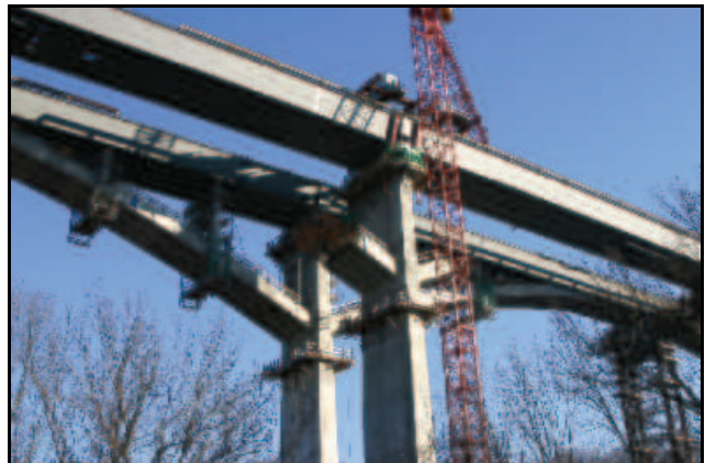
Abb. 2.1.76: Die Lockwitztalbrücke im Bau 2005.
