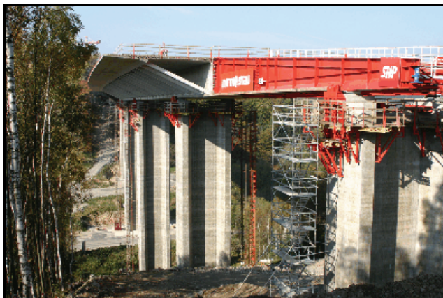
Abb. 2.1.106: Schieben der Fahrbahn auf die Pfeiler.
