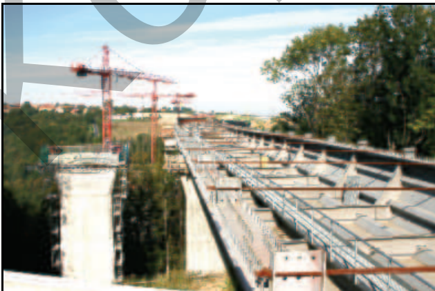
Abb. 2.1.75: Die Lockwitztalbrücke im Bau 2005.
