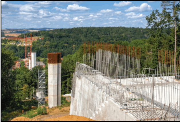
Abb. 2.1.142: Die Brückenbaustelle mit dem Widerlager am Hang der Viehleite. Von hier aus wird die Fahrbahn auf die Bücke geschoben 2020.
