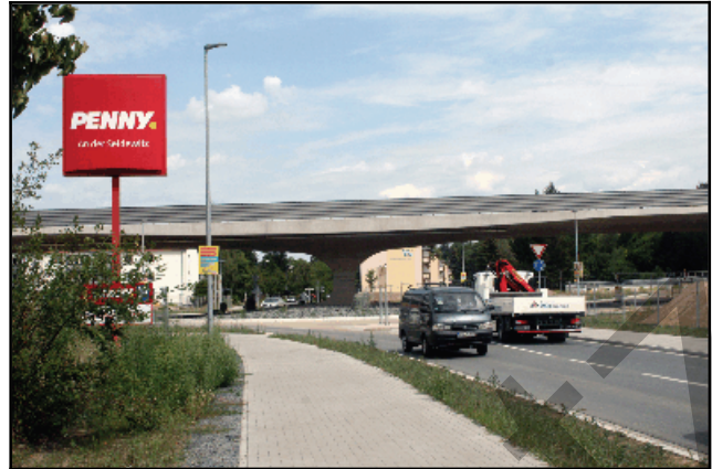
Abb. 2.1.136: Der Kreisverkehr unter der Brücke ist schon freigegeben 2020.
