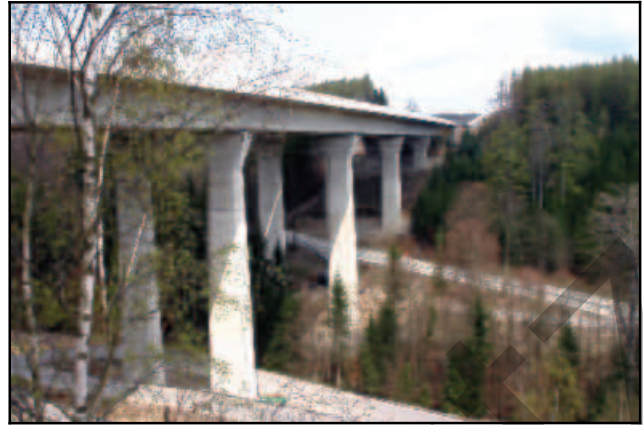
Abb. 2.1.94: Die fertige Nasenbachbrücke 2007. Die Baustraßen sind noch nicht zurückgebaut.
