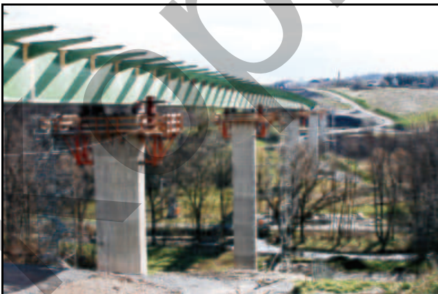
Abb. 2.1.118: Schieben des Unterbaus aus einer anderen Perspektive Jahre 2008.
