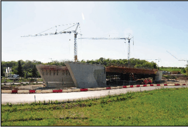
Abb. 2.1.135: Die Seidewitztalbrücke im Bau 2018. Foto: Wikipedia.
