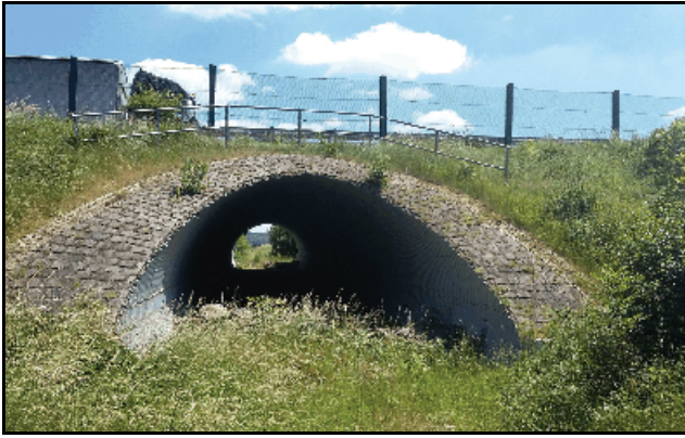
Abb. 2.1.128: Fledermaustunnel an der A17 bei Lauchitz in Richtung Friedrichswalde. Links hinten der Sensor.
