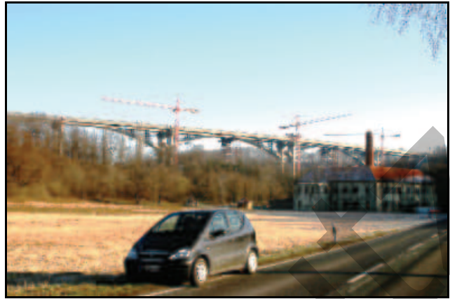
Abb. 2.1.78: Die Lockwitztalbrücke im Bau 2005.
