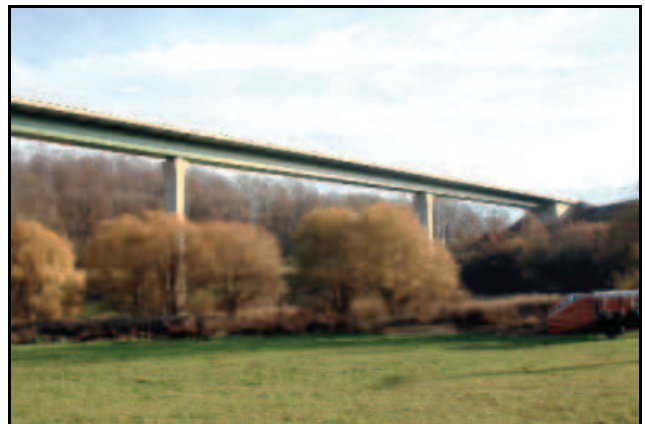
Abb. 2.1.119: Blick aus dem Bahretal auf die neue Zubringerbrücke 2008.
