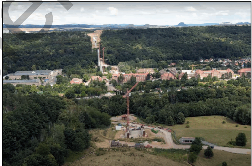
Abb. 2.1.140: Blick vom Kohlberg in das Gottleubatal in Richtung Viehleite mit den Baustellen für die Brückenpfeiler 2020. Der fertige Pfeiler hat an der Spitze immer ein umfangreiches Gerüst (hier als schwarzer Kopf an den letzten beiden fertigen Pfeilern zu erkennen), das die Umströmung des Windes so beeinflusst, dass keine Schwingungen am Pfeiler auftreten.
