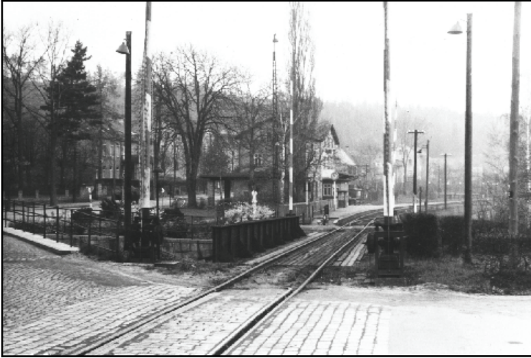
Abb. 2.2.15: Die Eisenbahnbrücke über die Gottleuba (im Hintergrund der Bahnhof Berggießhübel) um 1950.
