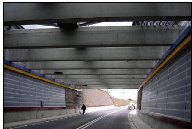
Abb. 2.1.133: Lärmschutztunnel in der Abfahrt Prohlis in Nickern 2006.
