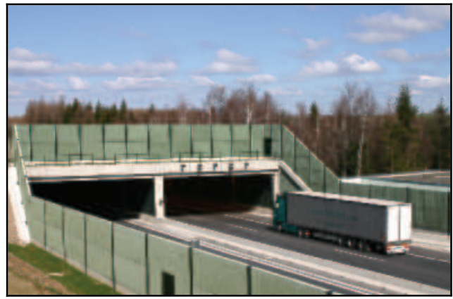
Abb. 2.1.98: Der fertige Landschaftstunnel 2007 mit den Absperrungen gegen unbefugtes Betreten.
