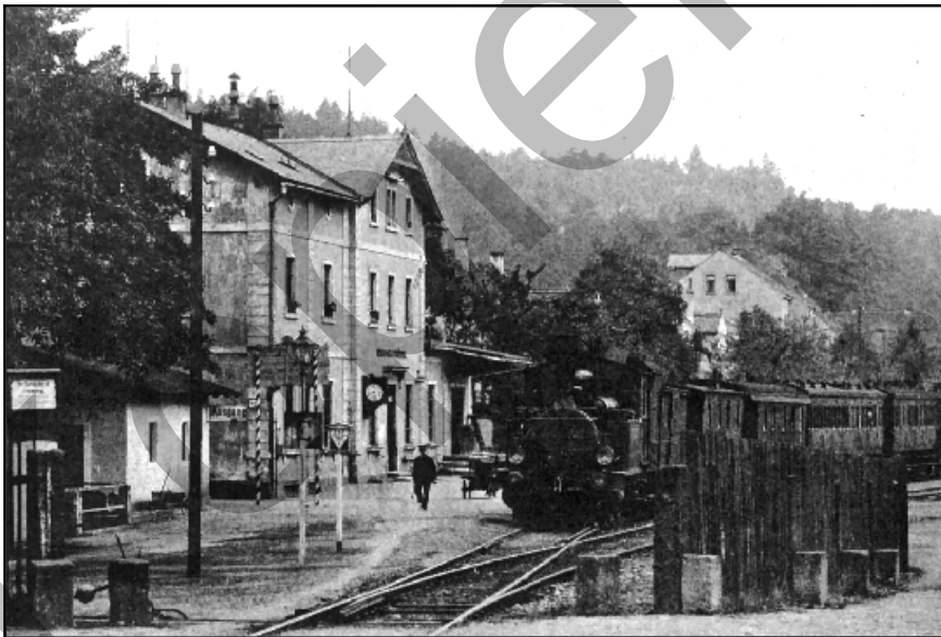
Abb. 2.2.13: Der Bahnhof Berggießhübel mit dem Gleis nach Gottleuba um 1910.
