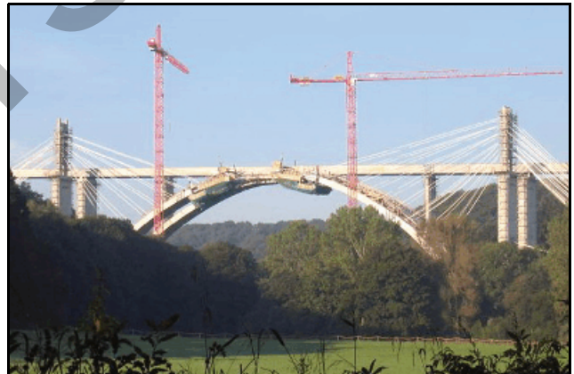
Abb. 2.1.84: Der Grundkörper für die Fahrbahn liegt.
