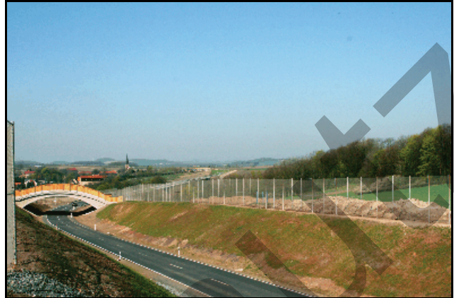
Abb. 2.1.121: Die Landschaftsbrücke bei Ottendorf kurz vor der Fertigstellung 2008.
