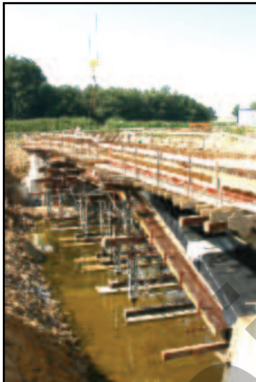
Abb. 2.1.89: Bau der Brücke für die S174 im Jahre 2005.
