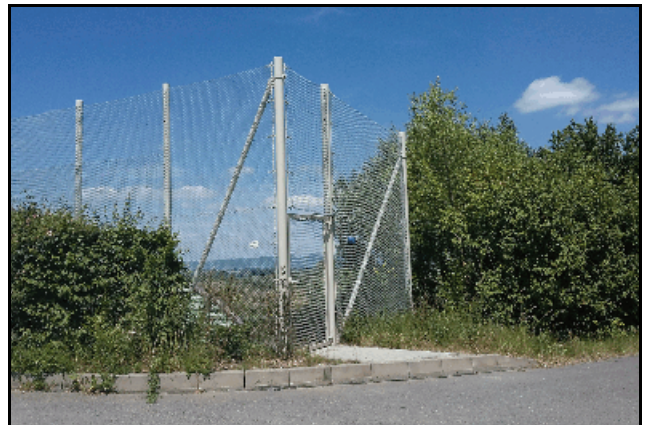
Abb. 2.1.127: Die Zäune für die Führung der Fledermäuse auf die Brücke im Jahre 2015.
