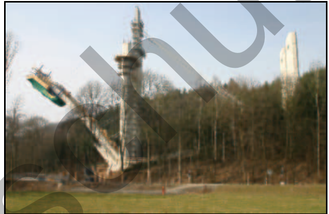
Abb. 2.1.82: Technologie des Freivorbaus 2005.
