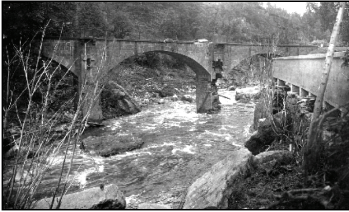
Abb. 2.2.34: Die Bahnbrücke oberhalb des Bahnhofes nach dem Hochwasser 1927. Blick flussabwärts. Rechts der Mühlgraben.
