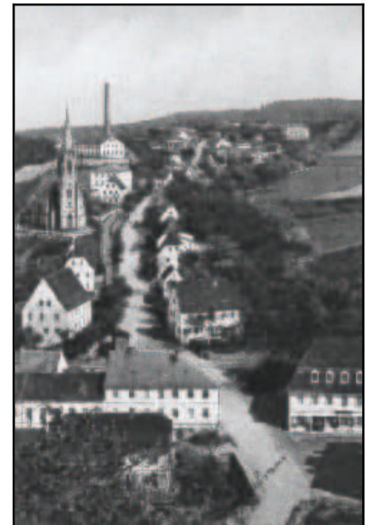
Abb. 2.2.14: Bahnübergang am Kirchberg mit dem Bahnwärterhäuschen 1910.
