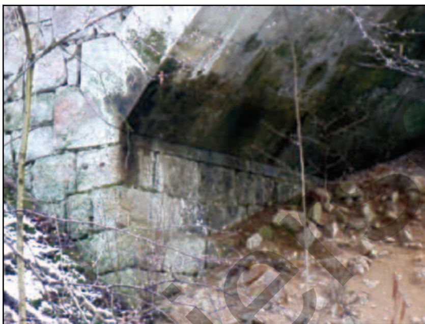
Abb. 2.2.63: Das Steingelenk an der steinernen Eisenbahnbrücke von 1880. Foto: Tobias Nitsche, Internet: Gottleubatalbahn.de.
