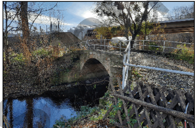
Abb. 2.1.138: Im Vordergrund die Brücke der Poststraße über die Seidewitz. Dahinter die neue Brücke der Umfahrung über die Seidewitz 2020.
