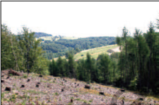
Abb. 2.1.95: Die ersten Rodungsarbeiten zum Landschaftstunnel 2004.
