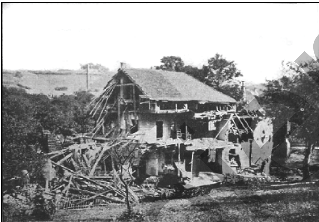
Abb. 4.1.13: Linkes Fabrik an der Gottleuba (rechts neben dem Eingang der späteren Heilstätte) nach dem Hochwasser von 1897. Abb. nach [4.5]
