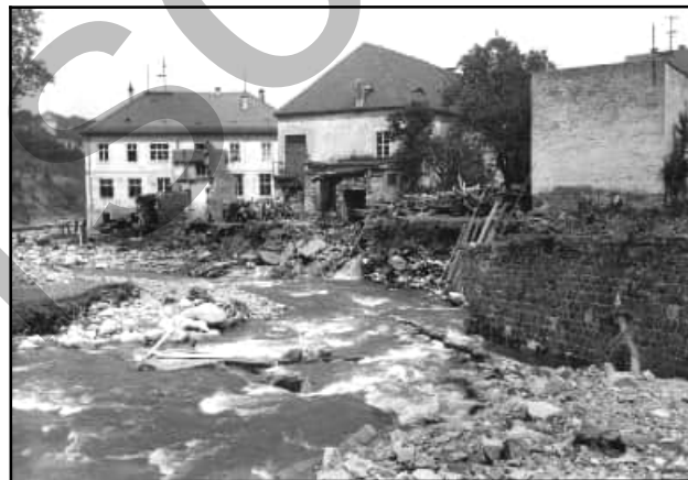
Abb. 4.11.35: Das Gelände der zerstörten Brauerei nach dem Hochwasser 1927.
