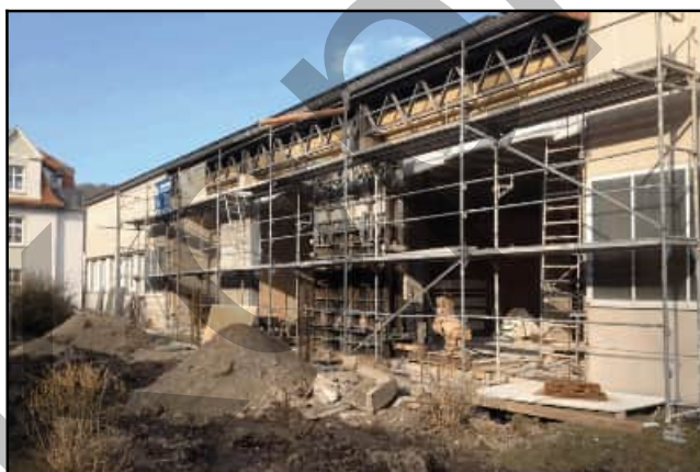
Abb. 4.13.6: Der Umbau der Halle für das Feuerwehrdepot Pirnaer Str. 57. Quelle: FFW Bad Gottleuba.
