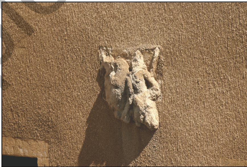
Abb. 4.5.9: Zustand des Reliefs 2007.
