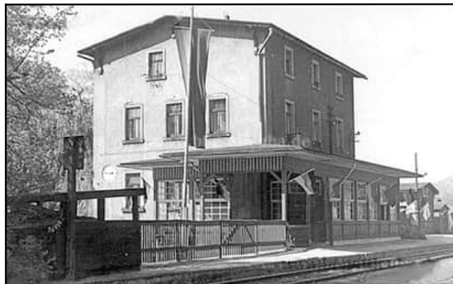
Abb. 4.1.16: Das Empfangsgebäude nach 1930. Abb. nach Ingolf Paul, Internet: Gottleubatalbahn.de.
