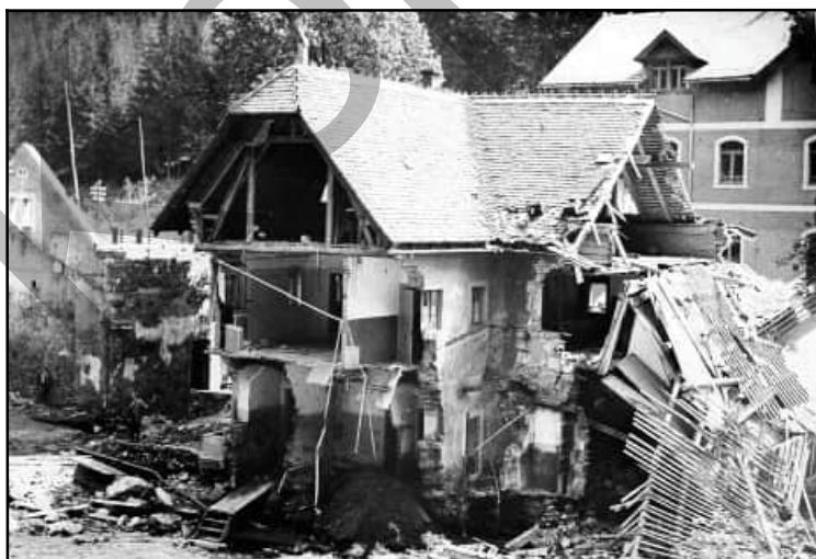
Abb. 4.12.11: Die Mühle nach dem Hochwasser 1927.
