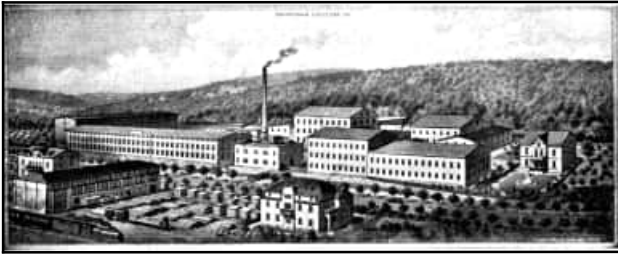
Abb. 4.11.19: Das Leinbrockwerk auf einer Firmenwerbeschrift 1930. Der Ziegelschornstein wurde 1984 abgerissen und durch einen neuen ersetzt.
