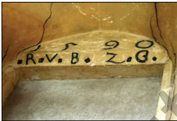
Abb. 4.3.7: Der ehem. Eingang zur Patronatsloge v. Bünaus.
