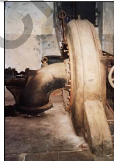
Abb. 4.12.20: Als Antrieb diente eine Wasserturbine.
