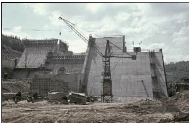
Abb. 4.9.10: Die Mauer ist eine Gewichtsmauer, was man hier sieht. Samml. Jürgen Freitag.
