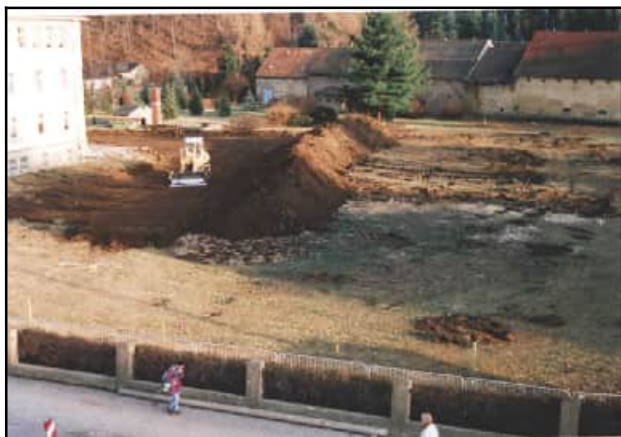
Abb. 4.10.8: Vorbereitung des Baugrundes für das neue Pflegeheim 1994. Foto: Stadtarchiv.
