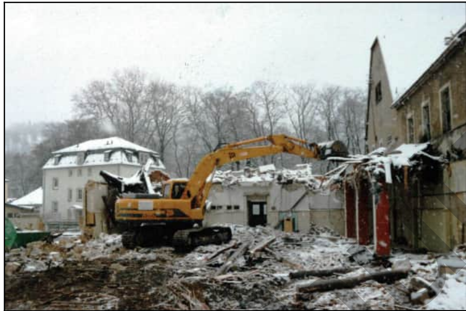
Abb. 4.10.28: Der Komplex des ehemaligen Schützenhauses wurde 1998 abgerissen.
