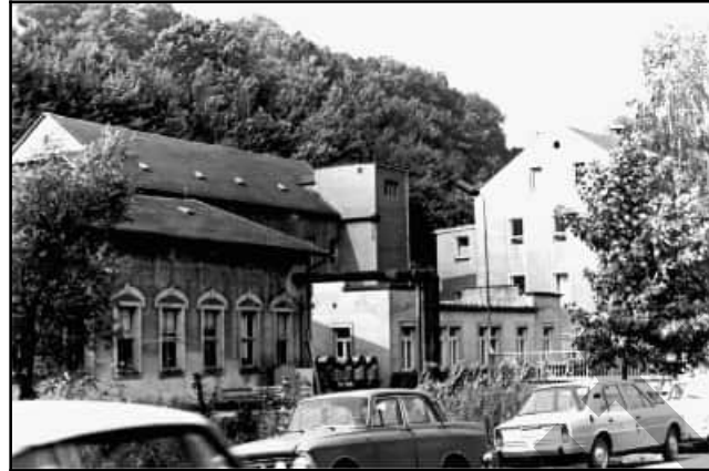
Abb. 4.11.12: Ansicht des ehemaligen Leinbrockwerkes um 1985. Samml. Eloma
