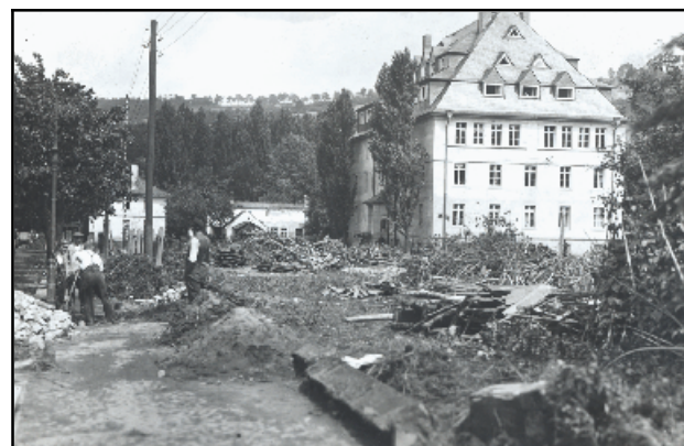
Abb. 4.10.4: Das Kinderversorgungshaus nach dem Hochwasser 1927.
