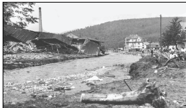
Abb. 4.11.10: Das Werk nach dem Hochwasser 1927. Blick stromab.
