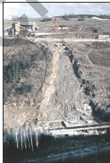
Abb. 4.9.6: Gründungsarbeiten 1968. Samml. J. Freitag.
