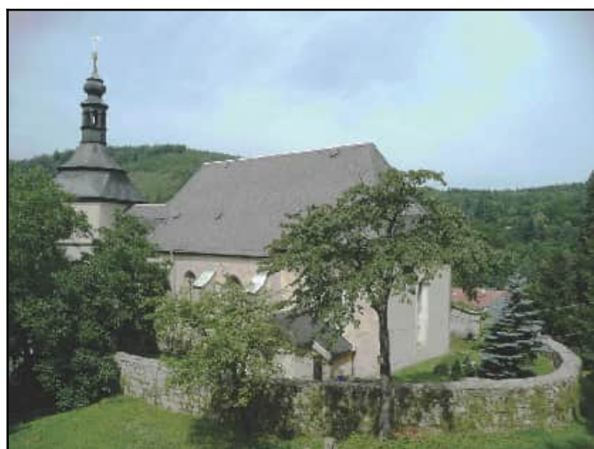
Abb. 4.3.2: Blick auf die Kirche in Richtung NW mit der heutigen Ringmauer 1990. Foto: Kirchgemeinde Bad Gottleuba.
