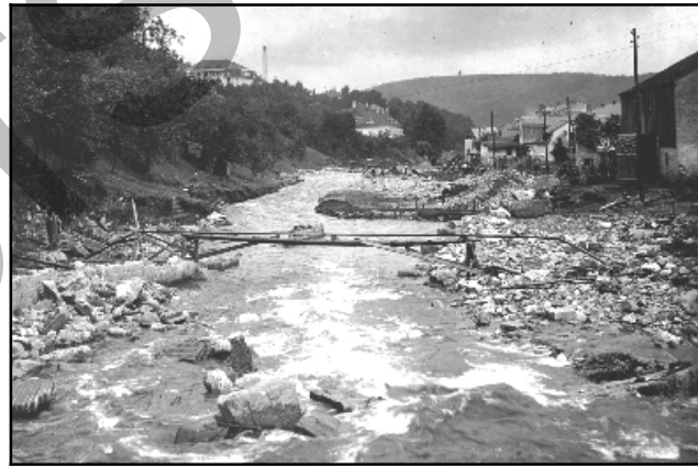
Abb. 4.1.31: Hochwasser 1927 unterhalb der Brücke Waldweg. Im Hintergrund die Heilstätte.
