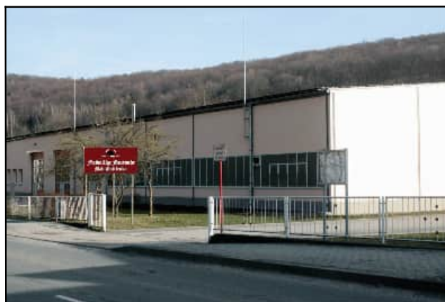
Abb. 4.13.7: Der neue Standort der Freiwilligen Feuerwehr Bad Gottleuba.
