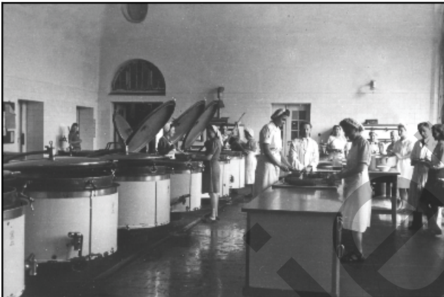
Abb. 4.2.22: Die Großküche der Heilstätte um 1950. Kapazität bis zu 1000 Portionen.
