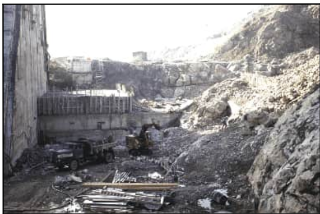
Abb. 4.9.9: Die Gründung der Talsperre war wegen des instabilen Grundes aufwendig. Samml. Jürgen Freitag.
