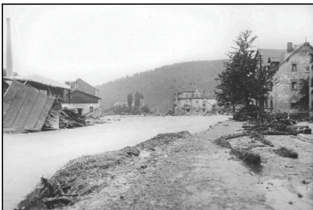
Abb. 4.1.33: Links das zerstörte Leinbrockwerk.
