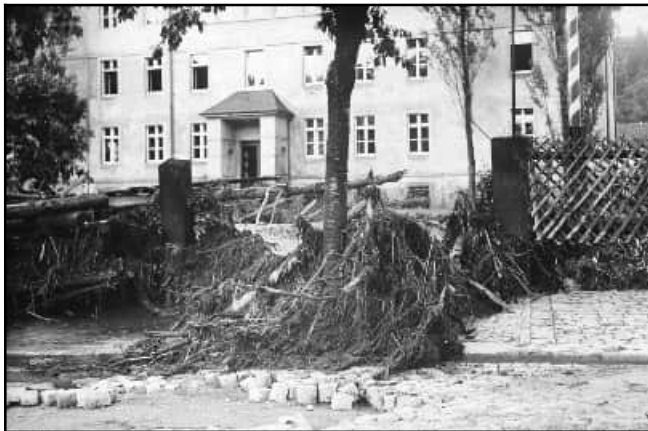
Abb. 4.1.36: Das ehem. Kinderversorghaus.
