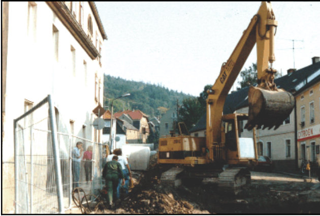
Abb. 4.1.68: Die Sanierung der Königstraße 1998.
