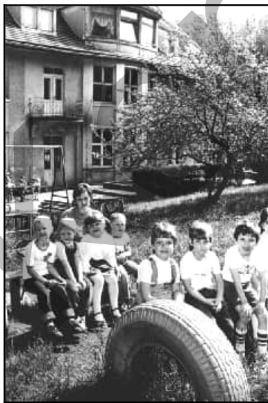
Abb. 4.4.16: Kindergarten im Goethepark 2 um 1980.
