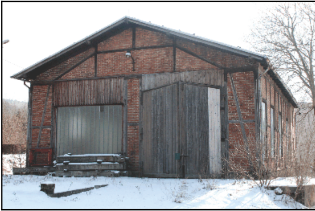
Abb. 4.1.21: Der von dem Bahnhof Berggießhübel 1905 umgesetzte Lockschuppen im Jahre 2012.
