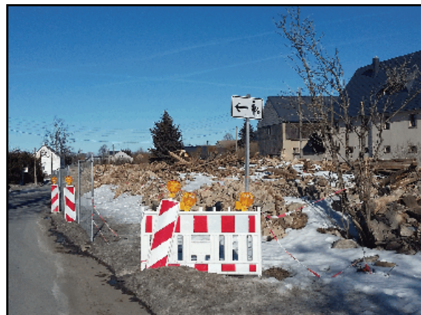
Abb. 6.5.66: Der Abriss Dez. 2016.
