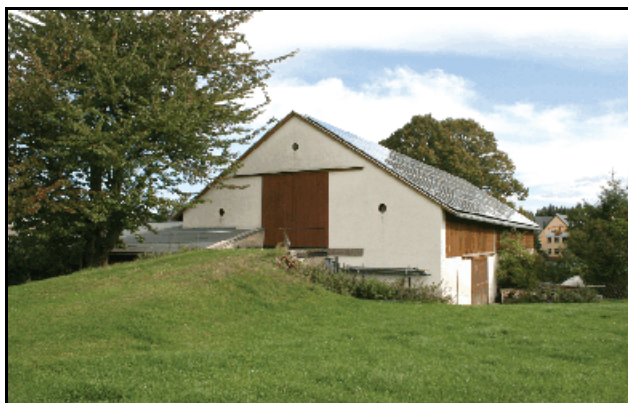
Abb. 6.5.26: Die Hocheinfahrt an der Scheune 2017.
