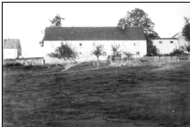
Abb. 6.5.35: Wohnstallhaus und Schuppen von der Straße aus. Foto: J. Helbig.
