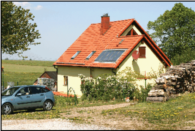
Abb. 6.1.60: Das Wohnhaus Börnersdorf Nr. 21.
