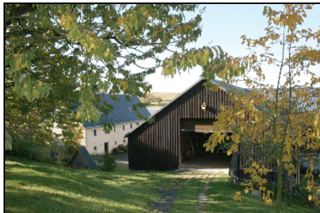
Abb. 6.5.56: Die Hocheinfahrt in die Scheune 2016.
