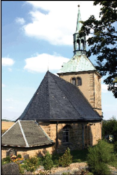
Abb. 6.2.1: Der Anbau für die Sakristei.
