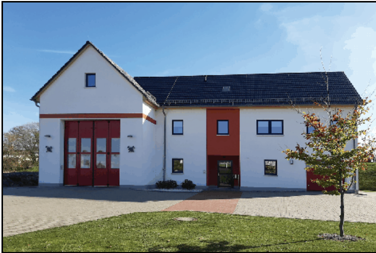
Abb. 6.6.3: Das neue Gebäude der Feuerwehr Börnersdorf im Jahre 2018.
