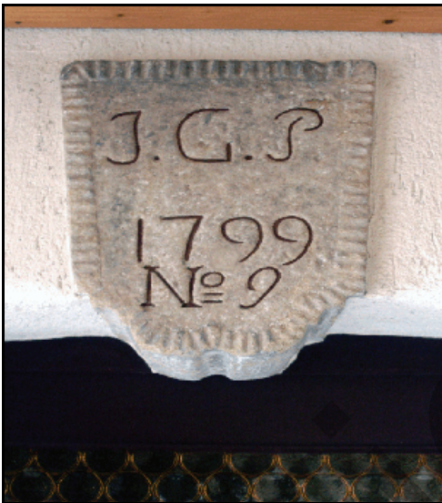
Abb. 6.5.50: Schlussstein am Wohnhaus "J.G.P./1799/No 9".
