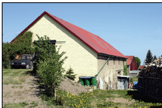
Abb. 6.1.59: Die Scheune von Gut Nr. 21 2017.
