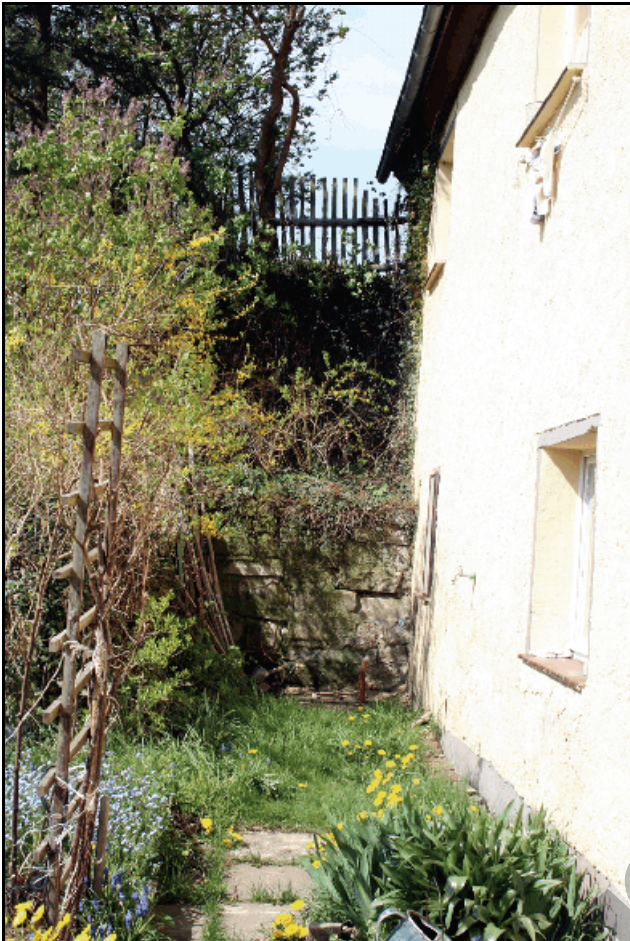
Abb. 6.8.13: Die ehemalige Radkammer der Mühle 2002.
