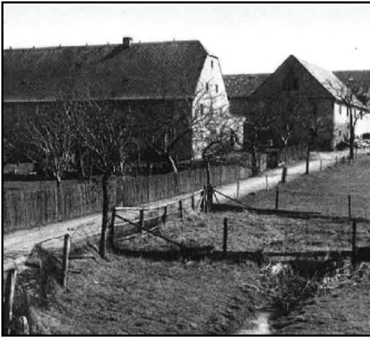
Abb. 6.5.57: Der Hof Börnersdorf Nr. 5 von Westen 1964. Foto: Jochen Helbig.
