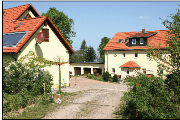
Abb. 6.1.61: Das Wohnhaus Börnersdorf Nr. 21.
