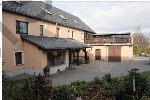
Abb. 6.5.70: Der Hof Nr. 16. Links das Wohnstallhaus mit dem neuen Vorhaus. Blick von der Scheune aus.
