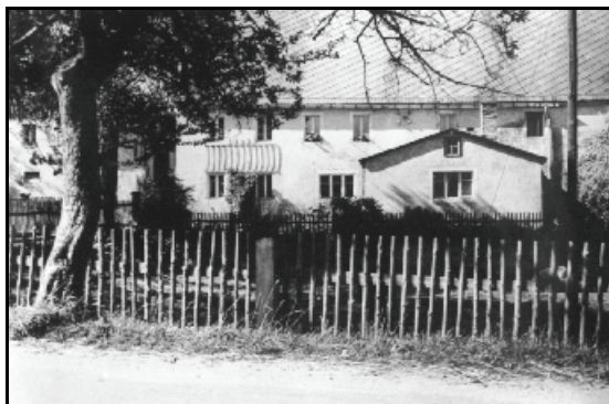
Abb. 6.5.19: Blick von der Straße zum Hof mit dem Wohnstallhaus 1964. Foto: J. Helbig.
