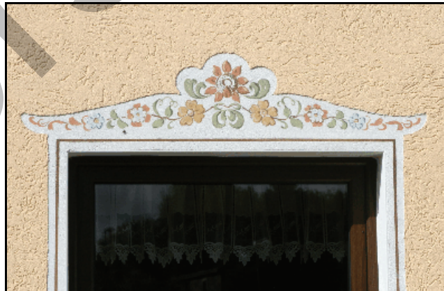
Abb. 6.1.57: Graffito Börnersdorf Nr. 39 über den Fenstern.
