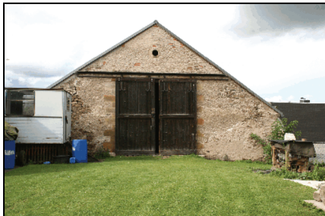
Abb. 6.5.41: Die Hocheinfahrt in die Scheune.
