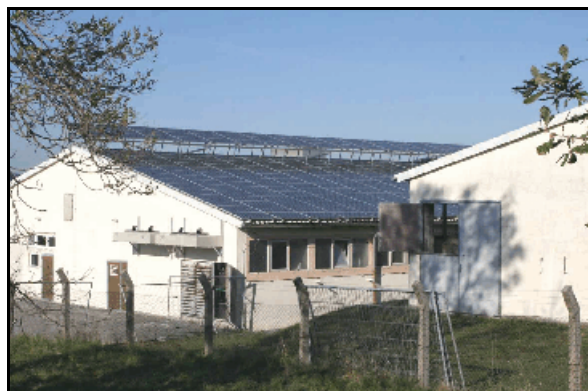
Abb. 6.4.6: Die Photovoltaikanlage auf den Dächern der Genossenschaft 2011.
