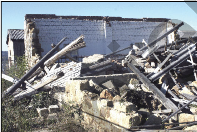
Abb. 9.1.119: Die Scheune wurde 2006 durch einen Sturm zerstört.
