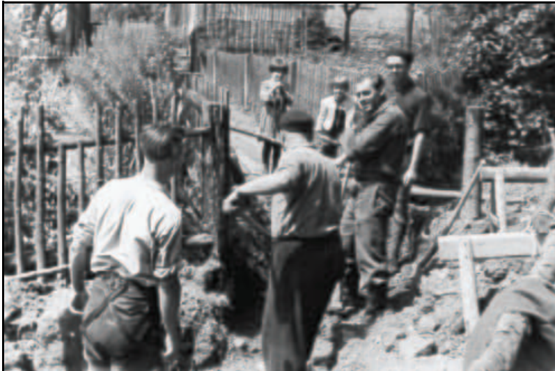
Abb. 9.1.55: Bau der Wasserleitung zur Schule 1976. Foto: Samml. Familie Fröhlich, Langenh.
