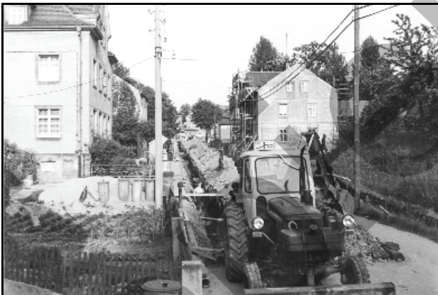
Abb. 9.1.56: Bau der Wasserleitung 1976. Samml. Familie Fröhlich, Langenh.
