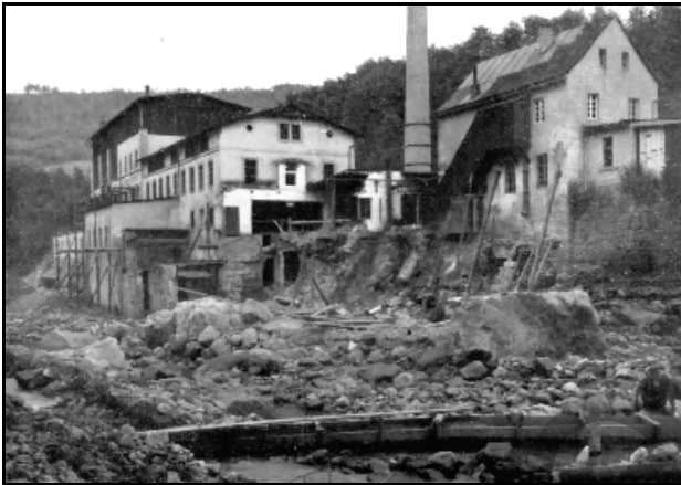
Abb. 9.1.169: Die Holzstofffabrik Lein nach dem Hochwasser 1927. Blick flussab.
