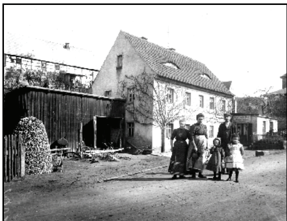
Abb. 9.1.184: Das Haus Hptstr. 89 im Jahre 1911. Der rechte Anbau ist das Warengeschäft, links die Schmiede. Samml. Familie Fröhlich, Langenh.
