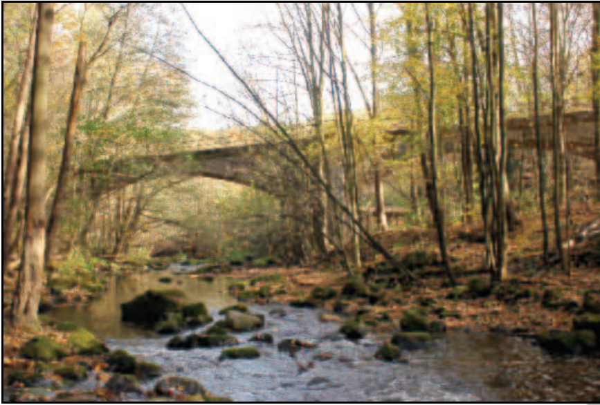
Abb. 9.1.58: Die Eisenbahnbrücke unterhalb des Bahnhofes Langenhennersdorf 2013.
