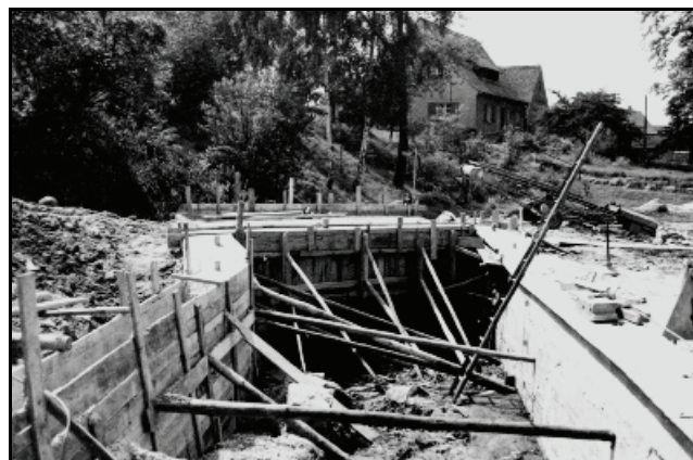
Abb. 9.1.63: Bau der Straßenbrücke zur Kaufhalle über den Dorfbach um 1977. Foto: Walter Kegel.
