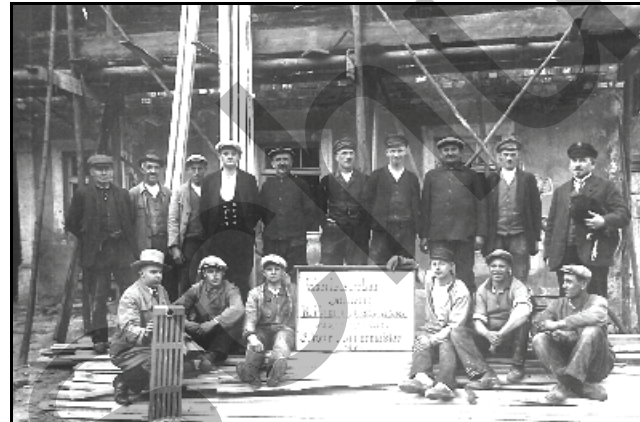
Abb. 9.1.131: Umbau des Wohnstallhauses 1933. Foto: Samml. Fam. Kunath.
