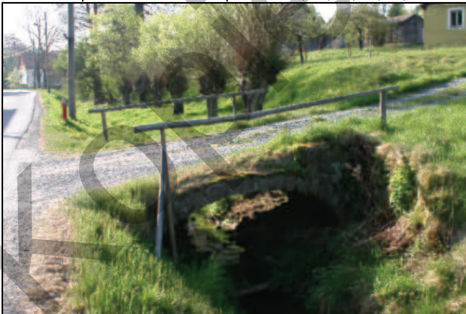
Abb. 9.1.127: Eine der vielen Gewölbebrücken über den Dorfbach bei Kuchler Hptstr. 56 2007. Diese Brücken zeugen von dem Geschick der Langenhennersdorfer Steinmetzen und sollen sorgfältig geschützt und gepflegt werden.
