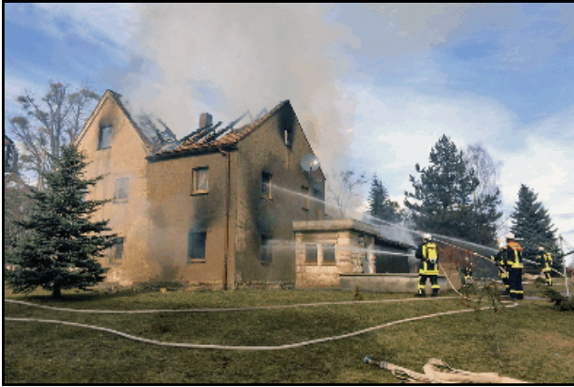
Abb. 9.1.250: Löscheinsatz mit Handspritzern im Ortsteil Forsthaus. Foto: FFW Langenhenn.
