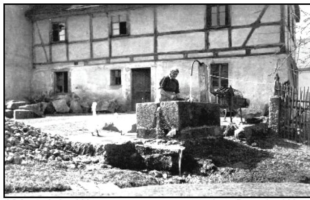
Abb. 9.1.17: Wasserversorgung vor dem Bau der Wasserleitung bei Familie Küchler Hptstr. 56 (1983 abgetragen). Samml. Familie Fröhlich, Langenh.
