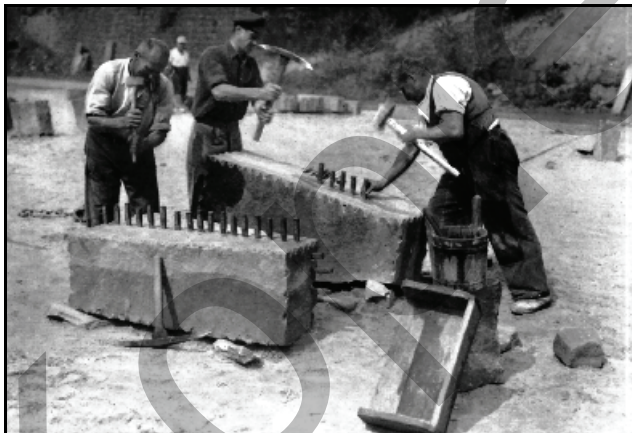
Abb. 9.1.201: Spalten und Bearbeiten des Sandsteins, wie es bis in die 1920er Jahre üblich war. Die Spuren der Eisenkeile sind in den Abbaugebieten überall zu finden.
