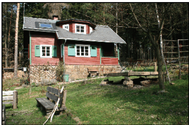
Abb. 9.3.18: Das ehemalige Verwaltungshaus der neuen Farm als Wochenendhaus 2014.
