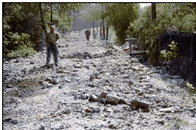
Abb. 9.1.52: Die Straße im Unterdorf nach den Wolkenbrüchen 1958. Foto: kol. Walter Kegel, Langenh.
