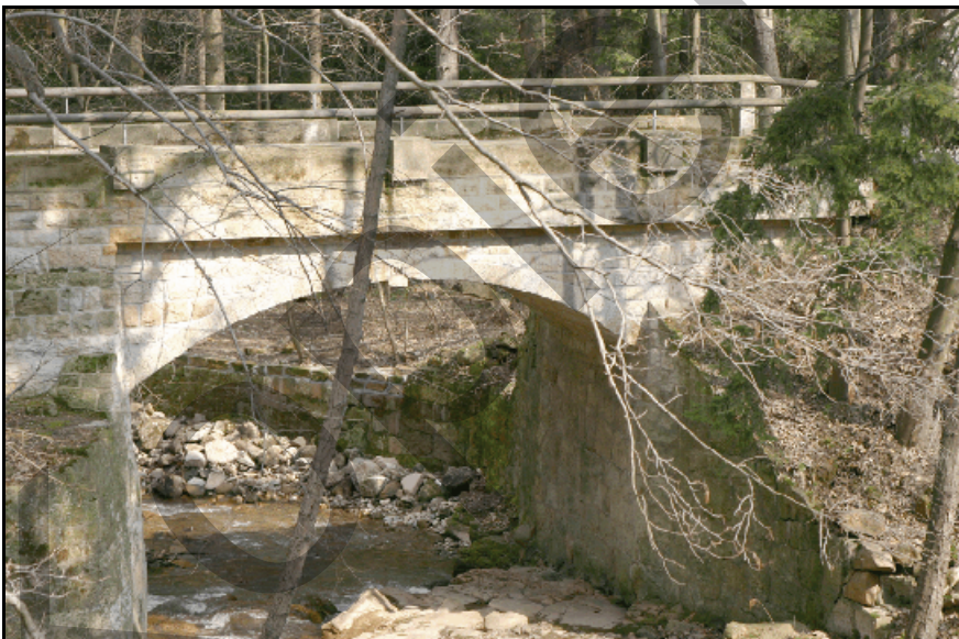
Abb. 9.1.149 Die 1897 erbaute und 1994 rekonstruierte alte Steinbrücke über die Bahra 2004.
