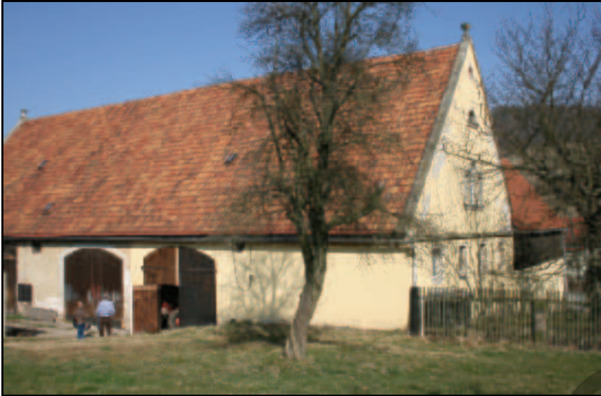
Abb. 9.1.135: Die aus behauenen Sandsteinquadern errichtete Scheune mit den Einfahrten. Zu beachten ist die schöne Giebelzier. Leider sind die Fleckmausgauben bei dem Dachumbau verschwunden.
