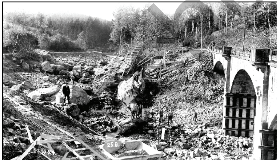
Abb. 9.1.23: Reparatur der steinernen Eisenbahnbrücke oberhalb des Bahnhofs 1927. Daneben wurde dann die neue Stahlbrücke errichtet. Foto Familie Blumenstein, Losatal
