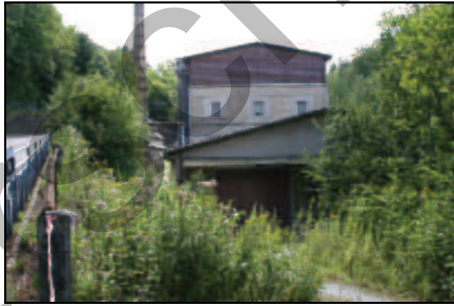
Abb. 9.1.170: Die ehemalige Holzstofffabrik Lein 2004. Blick flussaufwärts.
