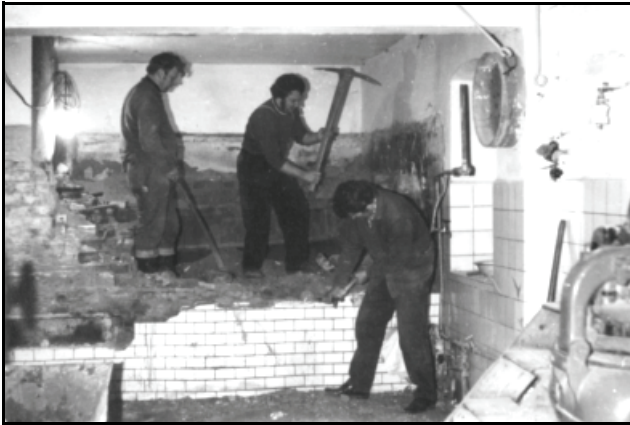
Abb. 9.1.195: Umbau der Bäckerei Weber zur Wohnung (Abriss des Backofens). Samml. Heimatverein Langenh.
