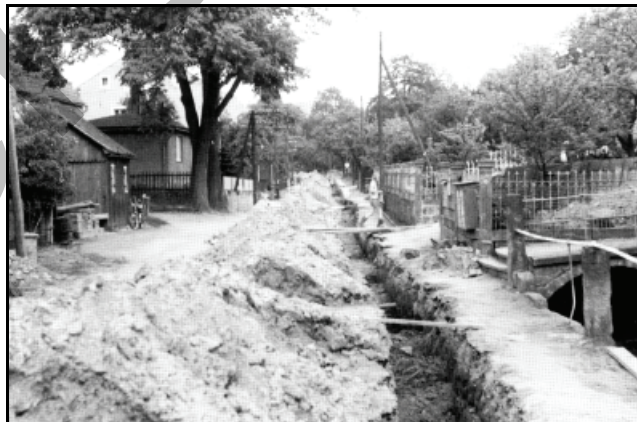
Abb. 9.1.57: Bau der Wasserleitung 1976. Samml. Familie Fröhlich, Langenh.
