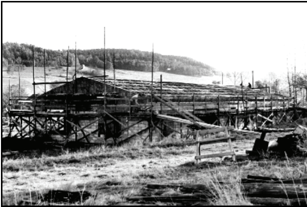
Abb. 9.1.95: Bau der Kinderkrippe 1979. Samml. Fam. Fröhlich, Langenhennersd.
