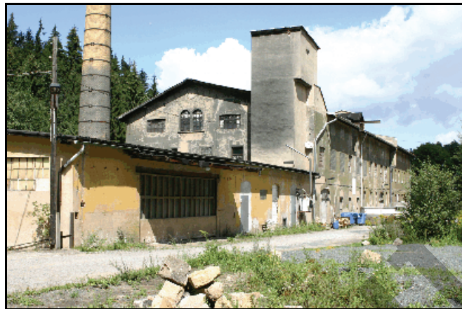
Abb. 9.1.153: Die ehemalige Papierfabrik Schmidt 2006.
