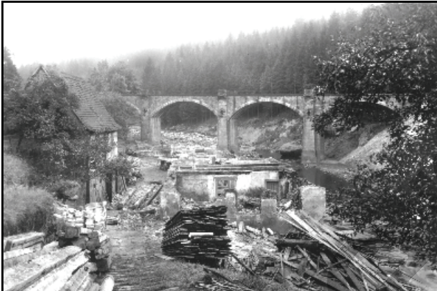
Abb. 9.1.159: Die zerstörte Heringmühle nach dem Hochwasser 1927. Blick flussauf.
