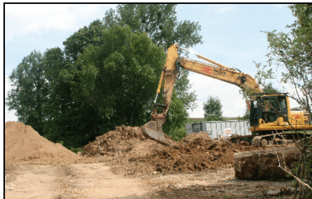
Abb. 9.1.122: Der Abriss im Juni 2017.
