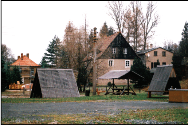
Abb. 10.12.7: Das ehemalige Gemeindeamt und die Arztpraxis (1996). Foto: Volker Ebert, Markersbach.
