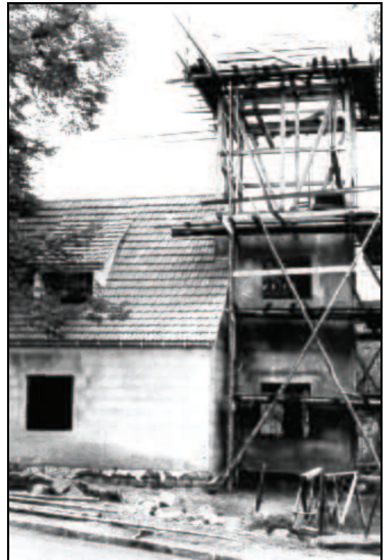
Abb. 10.10.3: Bau des Gerätehauses 1957. Foto: Archiv Markersbach.
