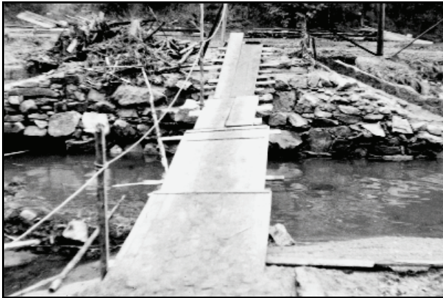
Abb. 10.4.7: Der Notsteg an der Schule nach dem Hochwasser 1957. Abb. Archiv Markersbach
