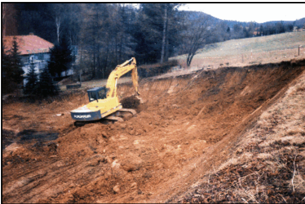
Abb. 10.12.9: Beginn der Baggerarbeiten 2000. Foto: Volker Ebert, Markersbach.
