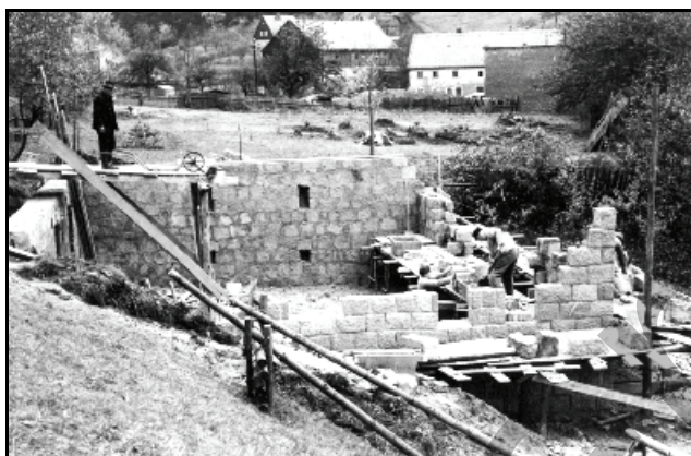
Abb. 10.3.23: Bau der neuen Leichenhalle 1958. Foto: Archiv Markersbach.
