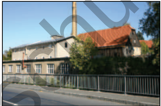
Abb. 10.8.7: Die Fabrik an dem Standort der Obermühle 2001. Dahinter das stattliche Wohnhaus des Mühlgutes.
