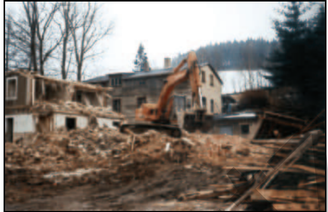
Abb. 10.12.8: Abriss der Gebäude 1999. Foto: Volker Ebert, Markersbach.
