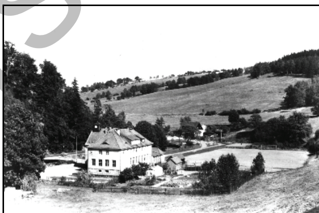
Abb. 10.4.4: Die 1927 erbaute ehemalige Schule von Markersbach und Hellendorf 1970.
