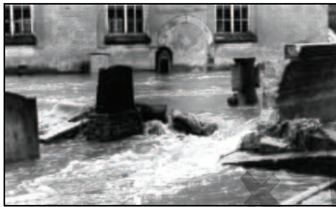
Abb. 10.3.22: Der beim Hochwasser 1957 überschwemmte Friedhof. Foto: Archiv Markersbach
