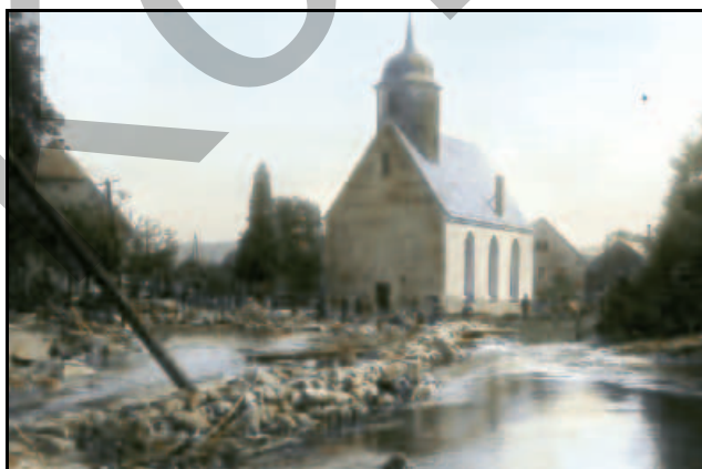
Abb. 10.3.19: Blick auf die Kirche nach dem Hochwasser. Foto: Wunderlich, Langenhennersdorf, kol.
