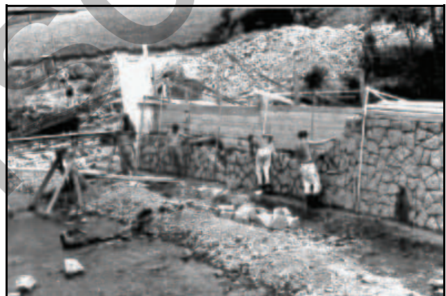
Abb. 10.1.17: Ausbau des Bachbettes nach dem Hochwasser 1957. Abb. Archiv Markersbach
