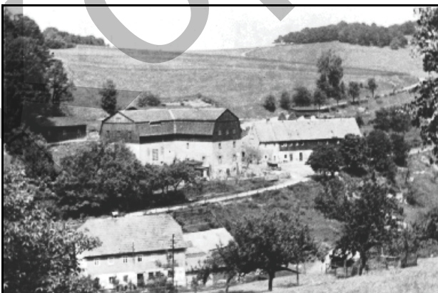
Abb. 12.1.7: Rechts oben das ehemalige Vorwerk am Waldweg 10 um 1985. Vorn die Schmiede.
