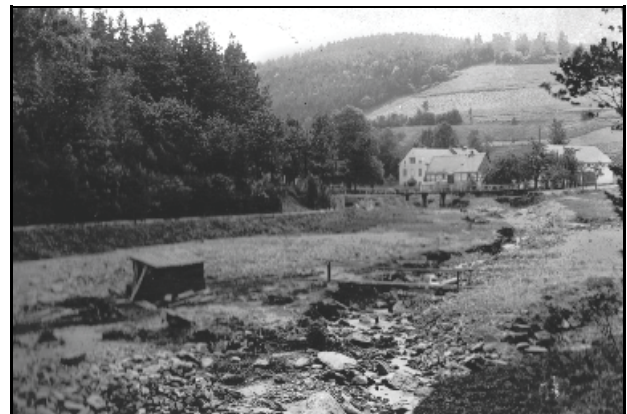
Abb. 12.1.4: Die Notbrücke in Richtung Haselberg 1928. Im Hintergrund die Fischermühle.
