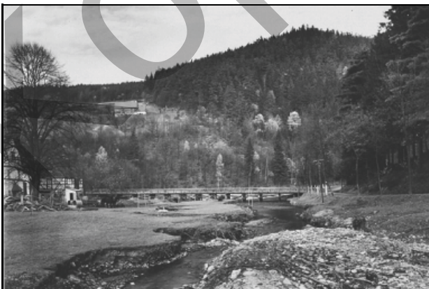
Abb. 12.1.3: Die Notbrücke über die Gottleuba in richtung Bähmühle 1928.
