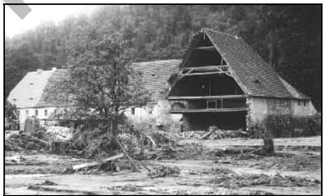
Abb. 12.2.10: Das Rittergut Giesenstein nach dem Hochwasser 1927.
