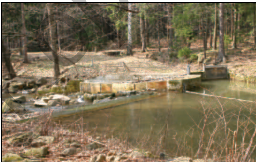
Abb. 3.72: Das neue Wehr für die Turbinen der ehemaligen Holzschleife 2008.
