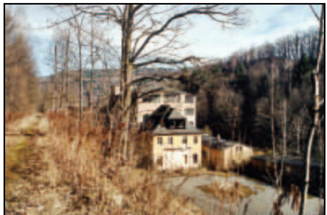
Abb. 2.119: Blick vom ehemaligen Bahnkörper auf die zerfallende Pappenfabrik Zacharias 2003.
