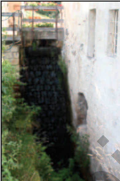
Abb. 4.45: Die riesige 4 m tiefe Radstube 2009.
