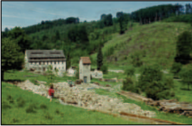
Abb. 2.21: Die Mühle ist 1973 abgerissen. Das Stötzner Haus steht noch. Foto: Bernd Kadner, Dresden.
