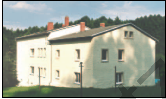
Abb. 3.56: Die zum Wohnhaus umgebaute Irrgangmühle 2006.
