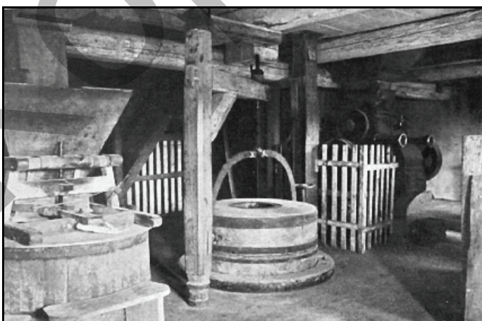
Abb. 4.19: Mahlstube Mühle Walddörfchen 1929. Rechts der Mühlsteingalgen. Landesverein Sächs. Heimatschutz .
