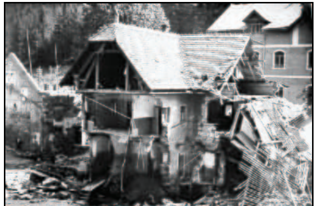
Abb. 2.42: Bähmühle nach dem Hochwasser 1927.
