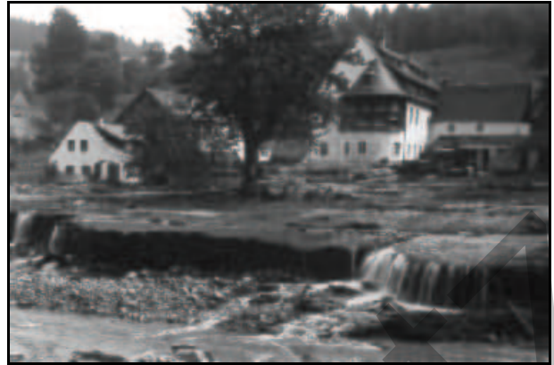
Abb. 2.16: Das Hammergut (in der Mitte das Haus von Stötzner) nach dem Hochwasser 1927. Foto: Landesverein Sächs. Heimatschutz [13].
