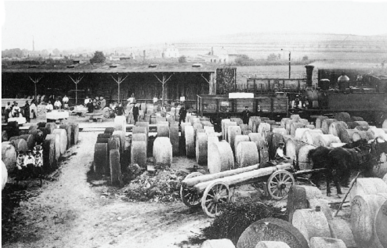
Abb. 1.9: Mühl- und Schleifensteinlager in Pirna um 1910.
