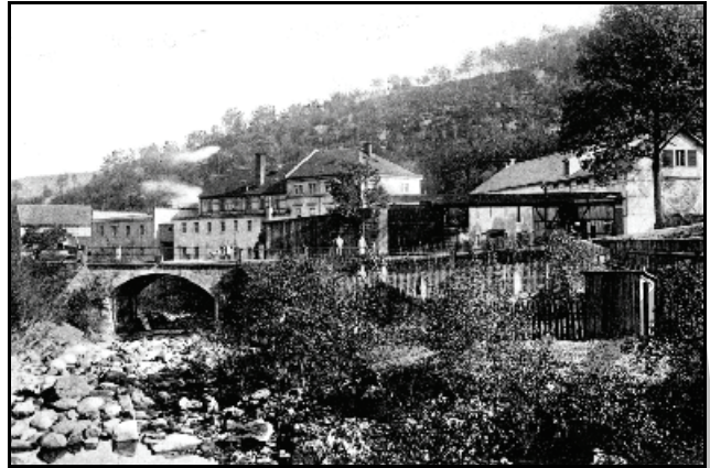
Abb. 2.115: Blick flussab auf die Bähmühle um 1950.
