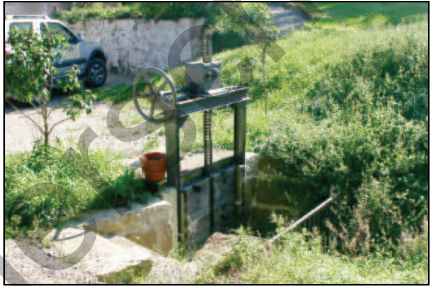
Abb. 4.46: Der Mühlgraben der Eulmühle 2002.
