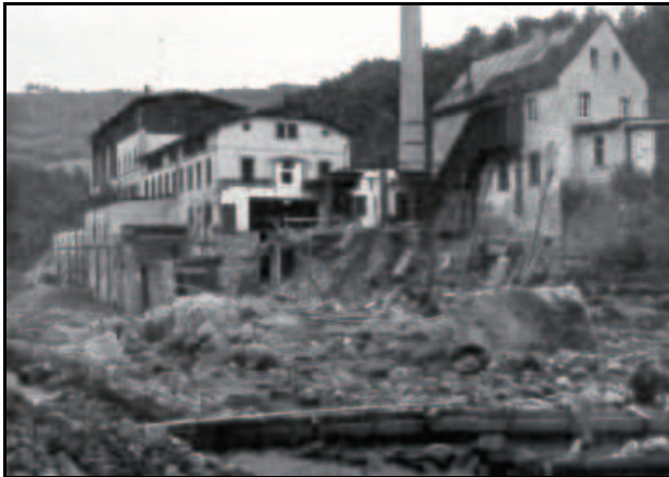
Abb. 2.120: Die Holzstofffabrik Lein nach dem Hochwasser 1927. Blick flussab.
