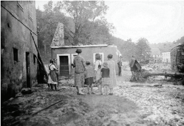
Abb. 2.74: Die Zerstörungen im Bereich der Ehrlichmühle (im Hintergrund) nach dem Hochwasser 1927.
