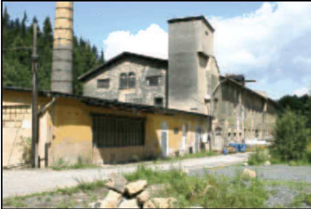
Abb. 2.105: Die ehemalige Papierfabrik Schmidt 2002.
