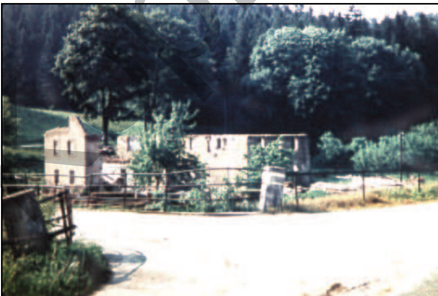
Abb. 2.25: Abriss der Paustmühle 1973. Foto: Archiv Oelsen.
