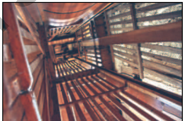
Abb. 3.39: Der Fahrstuhlschacht 2015. F: N. Kaiser.
