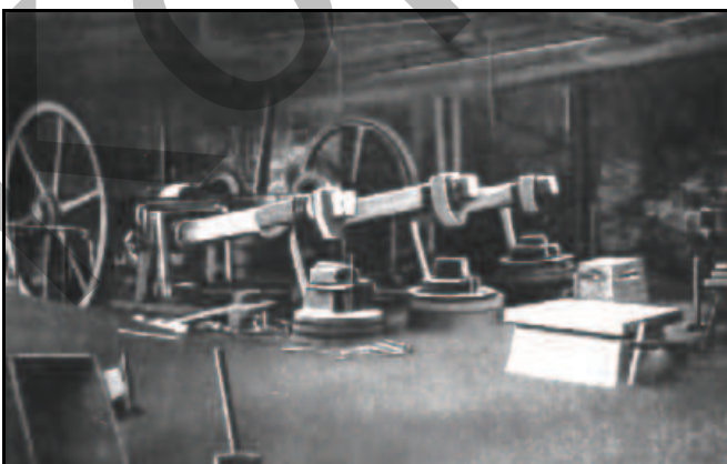
Abb. 2.88: : Die drei Hämmer des Oberhammers. Foto: Archiv Berggießhübel.
