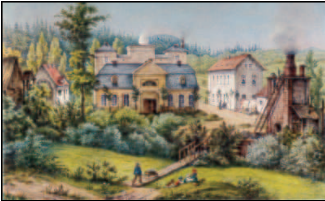
Abb. 2.90: Die Einsiedelsche Eisenhütte um 1835. Rechts der alte Holzkohlehochofen und links der Hammer. Der Anbau an dem Hochofen beherbergt die wassergetriebene Windanlage. In der Mitte der neue Hochofen mit den beiden Fördertürmen und davor das Gießhaus. Lithographie von Traugott Faber.
