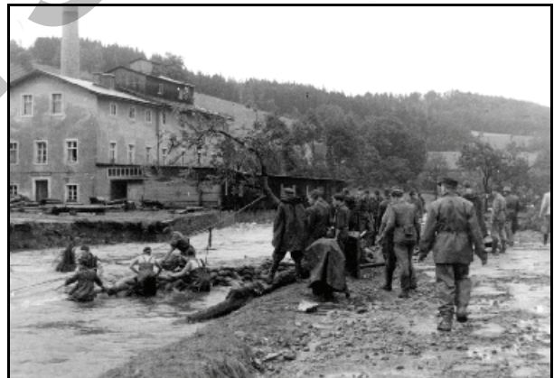
Abb. 1.10.71: Das Bachbett der Bahra an der Markersbacher Obermühle beim Hochwasser 1957.
