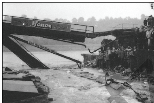
Abb. 1.10.75: Die zerstörte Eisenbahnbrücke der Staatsbahn Dresden - Prag an der Elbe.
