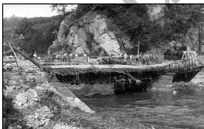
Abb. 1.8.19: Die Brücke an der Schlossmühle in Weesenstein. Foto: [1.45].
