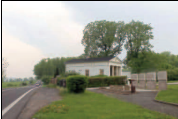
Abb. 1.6.39: Gedächtnishalle mit den Erläuterungstafeln direkt neben der Nationalstraße.
