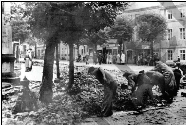
Abb. 1.10.70: Aufräumarbeiten nach der Hochwasser 1957 am Markt in Bad Gottleuba.
