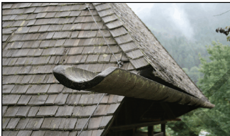
Abb. 1.5.17: Ein fertiges Schindeldach mit Holzrinne. Foto: Wikipedia.
