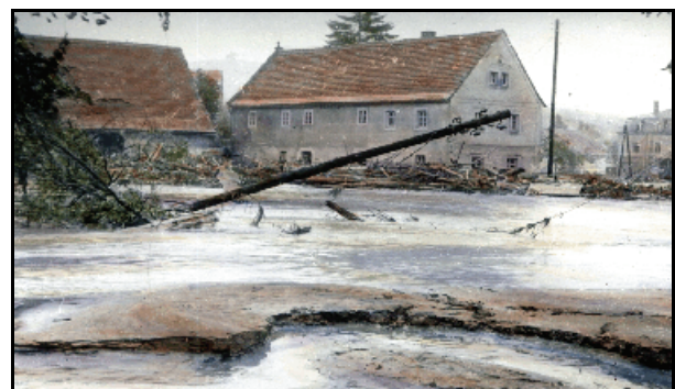
Abb. 1.10.73: Schäden in Neundorf beim Hochwasser 1957. Foto: kol. Kegel.
