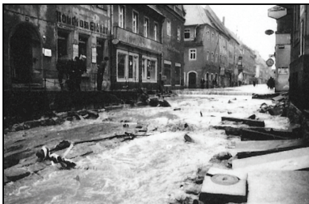
Abb. 1.10.74: Das neue Bachbett der Gottleuba in der Dohnaer Straße einige Tage nach der Flut.
