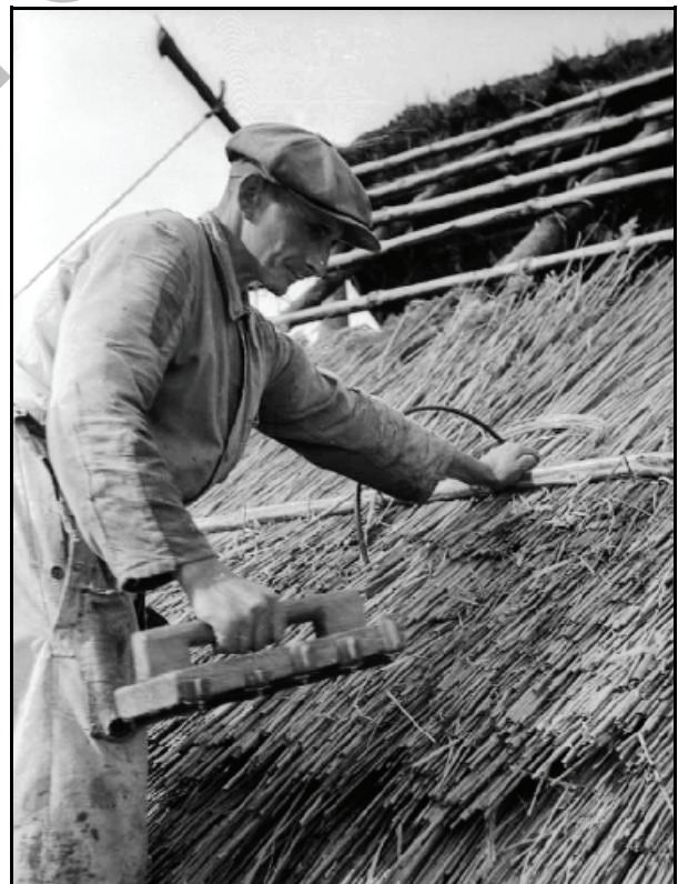
Abb. 1.5.14: Das Decken eines Strohdaches. Foto: Wikipedia.
