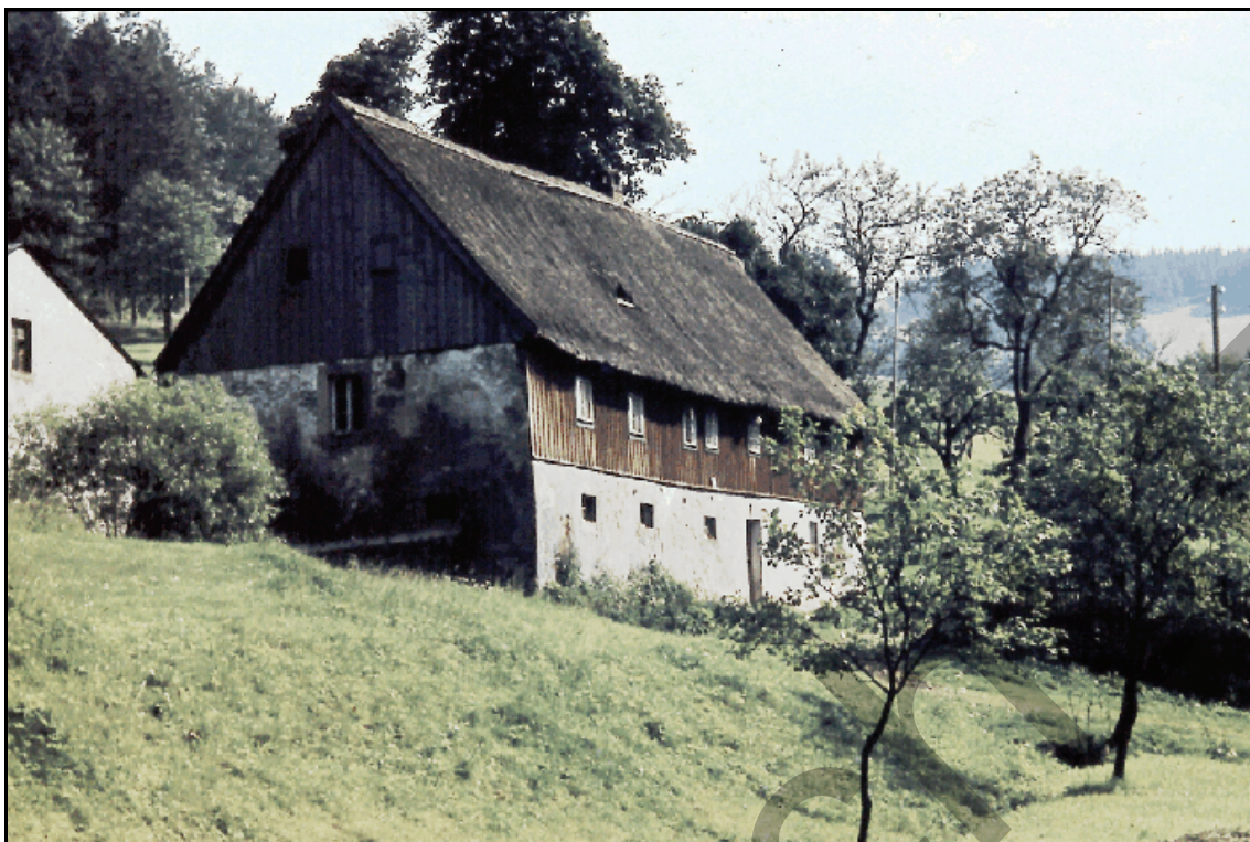
Abb. 1.5.15: Strohgedecktes Bauernhaus in der Gemeinde Oelsengründ 1950.
