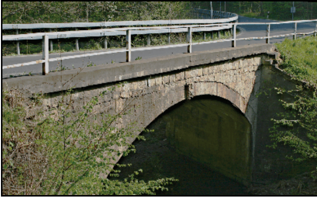
Abb. 5.14.11: Die alte Brücke mit dem Schlussstein mit Blick in Richtung Zwiesel.
