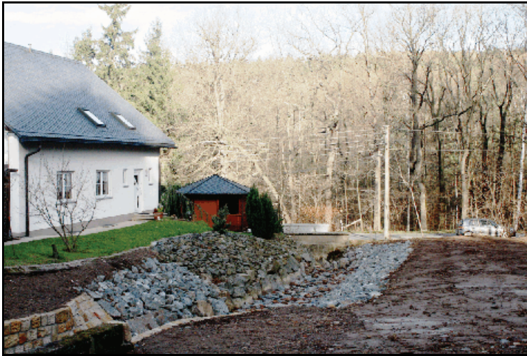
Abb. 5.1.109: Der ausgebaute Fuchsbach oberhalb der Talstraße 2010.
