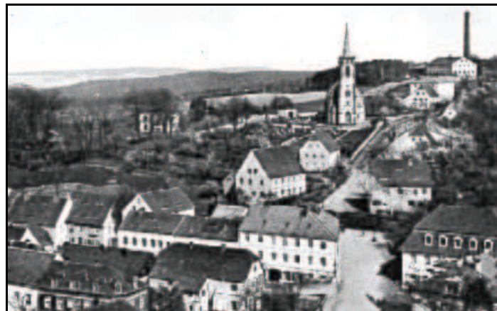
Abb. 5.1.24: Blick vom Schauhübel auf den Kirchberg mit dem Schachtgebäude um 1900. Das Haus unter der Kirche ist die alte Schule von 1822 darunter das Haus Schönbach (Abriss 1906). Über der Kirche das Haus der Familie Gregor (Abriss 1969).
