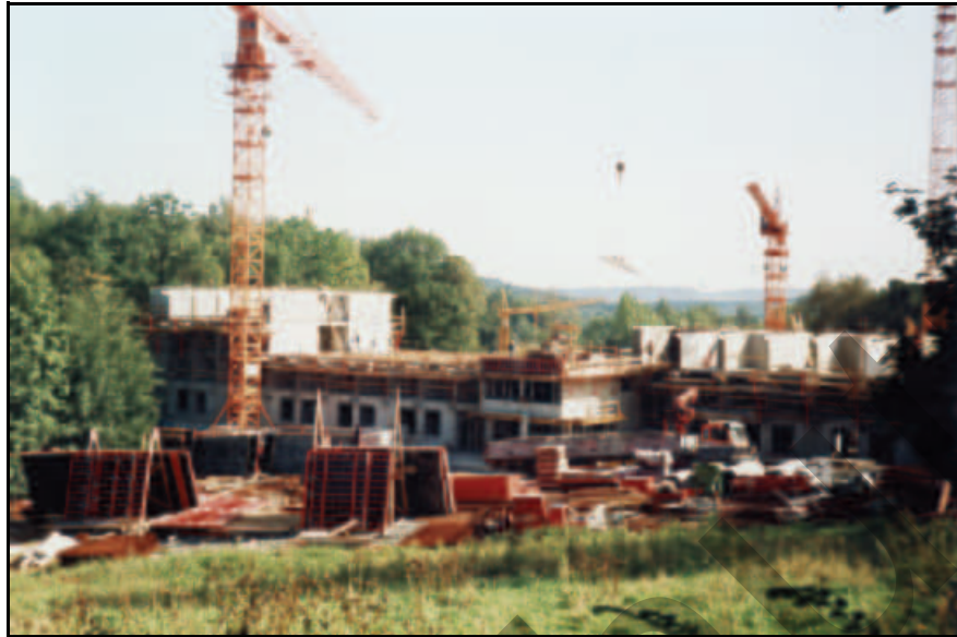
Abb. 5.2.31: Die Klinik im Bau. Foto: Klaus Seeger, Bergg.
