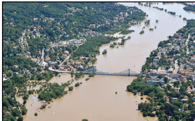
Abb. 5.1.111: Das Blaue Wunder bei dem Hochwasser. Man erkennt, dass die Uferbereiche von Blasewitz und Laubegast unter Wasser stehen. Foto: Wikipedia.
