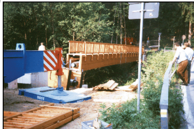
Abb. 5.1.91: Verlegung des Abwasserkanals über die Gottleuba mit der Fußwegbrücke an der Einmündung der Bahra in die Gottleuba. Foto: Klaus Seeger, Bergg.
