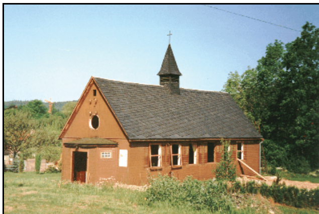
Abb. 5.3.26: Der Abriss der Kapelle 1992.
