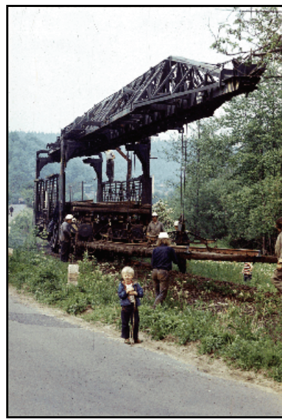
Abb. 5.1.20: Rückbau der Gleise. Foto: Samml. Möritz, Bergg.
