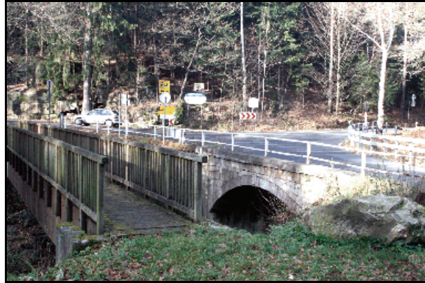
Abb. 5.14.12: Die alte Brücke mit Blick in Richtung Langenhennersdorf mit der hölzernen Fußgänger- und Rohrbrücke.
