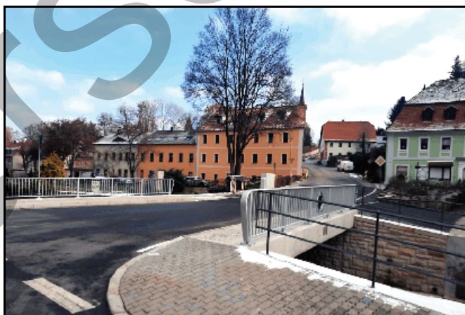
Abb. 5.1.118: Die fertige Brücke im November 2020.
