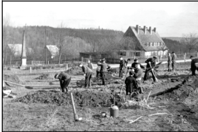
Abb. 5.1.89: Bau der Siedlung am Kaffeeberg 1974.
