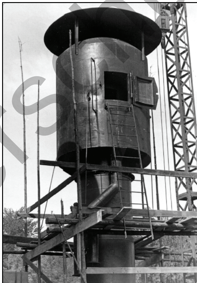
Abb. 5.13.9: Aufbau des 3. Kupolofens 1956. Foto: Samml. Frau Streit, Bergg.
