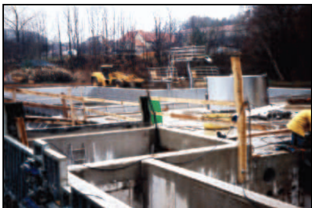
Abb. 5.8.7: Betonierung der Becken.
