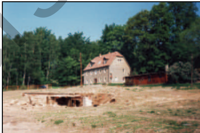
Abb. 5.5.17: Abriss der Gärtnerei 1990.
