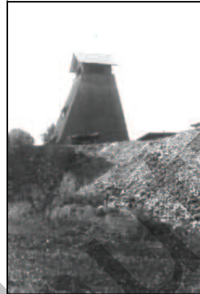
Abb. 5.1.70: Der Förderturm auf der Prinzessinhöhe 1940.
