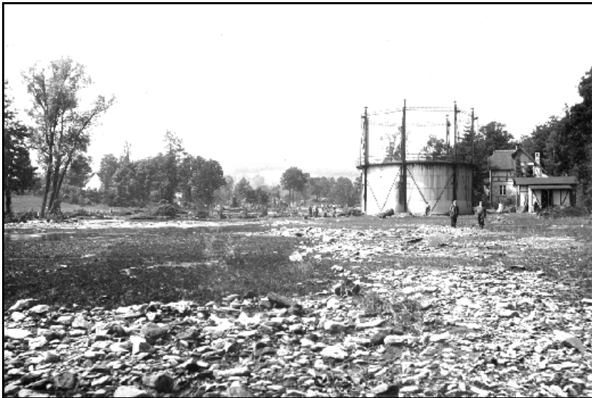
Abb. 5.1.7: Der Gasometer an der linken Seite der Gottleuba unterhalb des Bades nach dem Hochwasser 1957. Blick flussauf.
