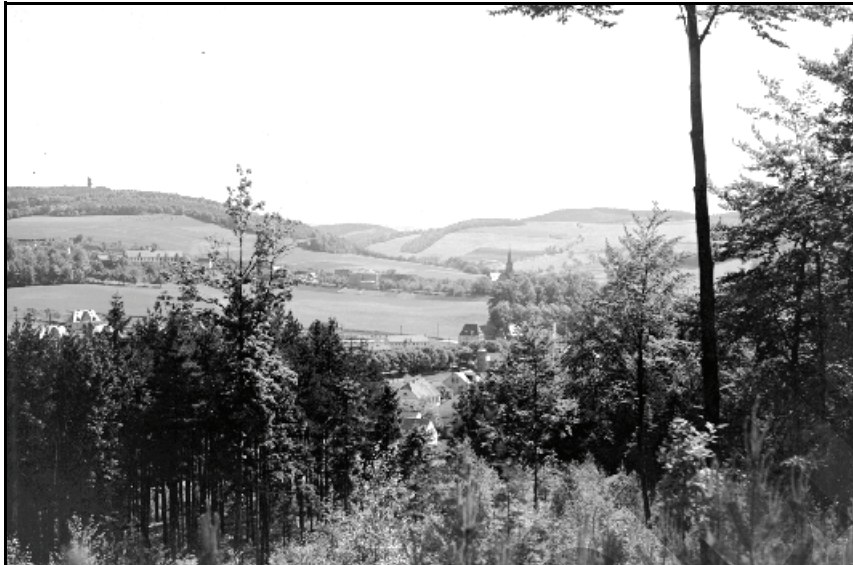
Abb. 5.1.62: Die Bebauung der Siedlung um 1930.
