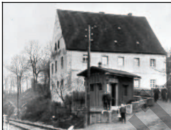
Abb. 5.1.13: Der Bahnübergang am Kirchberg mit dem Bahnwärterhäuschen 1905. Das Haus wurde 1906 wegen eines Bergschadens abgerissen. Foto: Samml. Fam. Mörbitz
