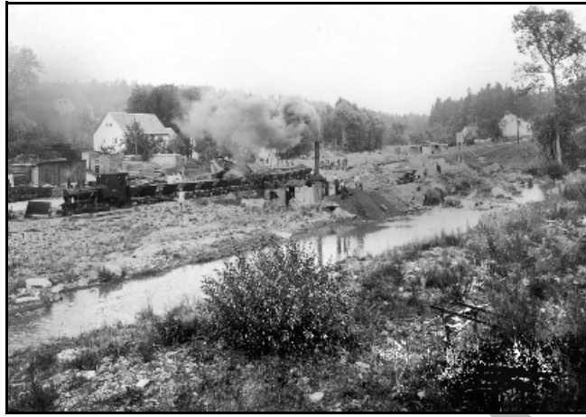
Abb. 5.1.54: Wiederherstellung des Bachbettes in Zwiesel. Links im Hintergrund die "Zwieselmühle"
