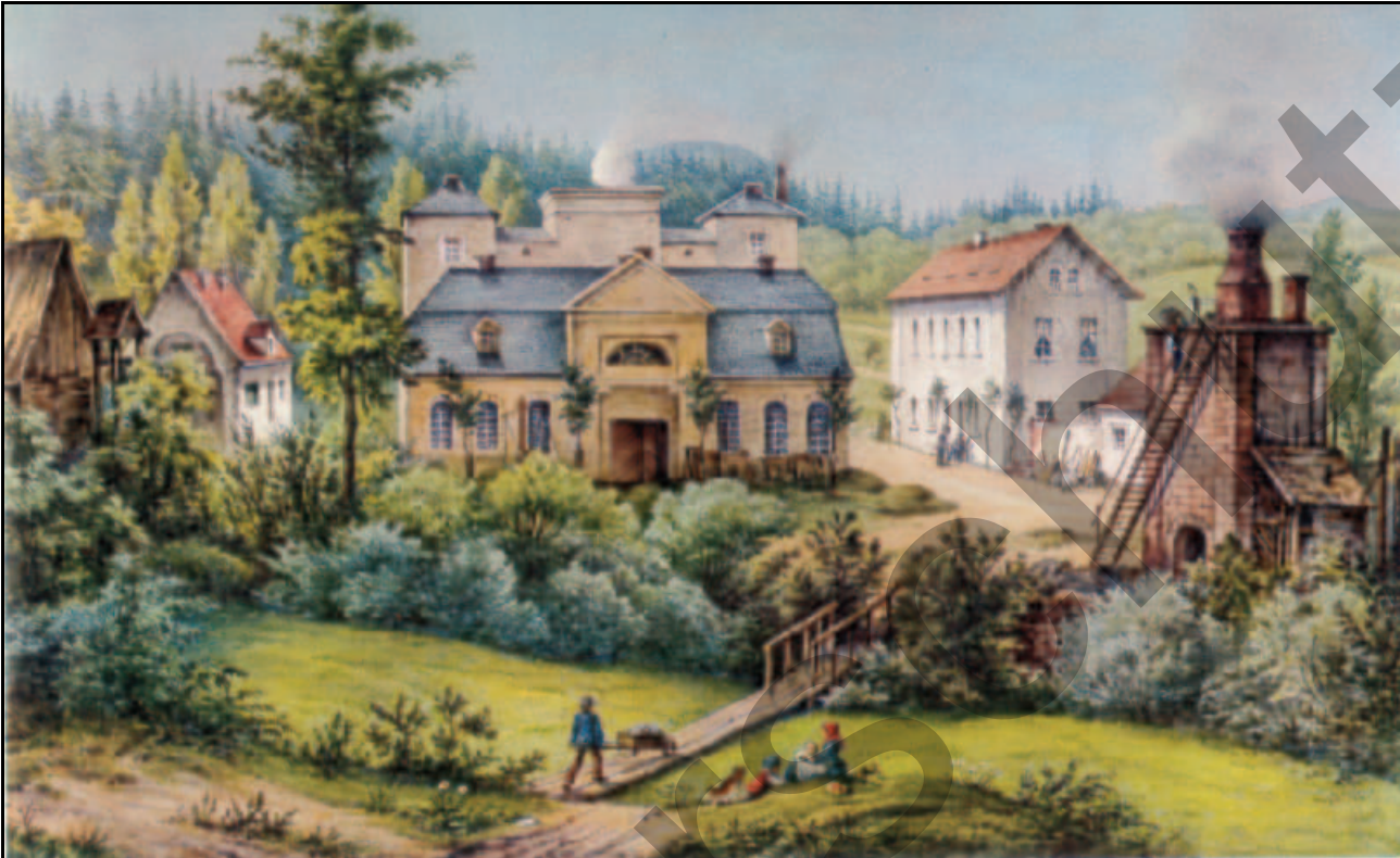
Abb. 5.13.1: Berggießhübeler Eisenhütte um 1835. Rechts der alte (Cramersche?) Holzkohlehochofen, von einer ähnlichen Konstruktion, wie er in Brausenstein gerettet wurde. Der Anbau an dem Hochofen beherbergt die wassergetriebene Windanlage. In der Mitte der neue Hochofen mit den beiden Fördertürmen und davor das Gießhaus. Aquarell nach einer Lithographie von Traugott Faber. Quelle Salewski [5.46].
