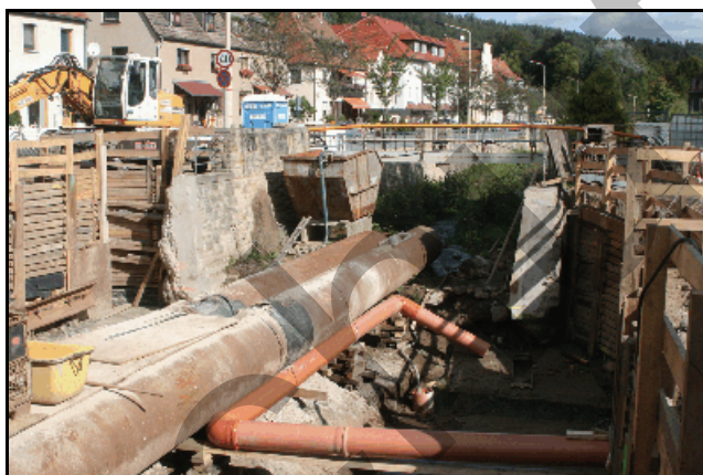
Abb. 5.1.116: Die Brücke ist weg und die Versorgungsleitungen gesichert im September 2019.
