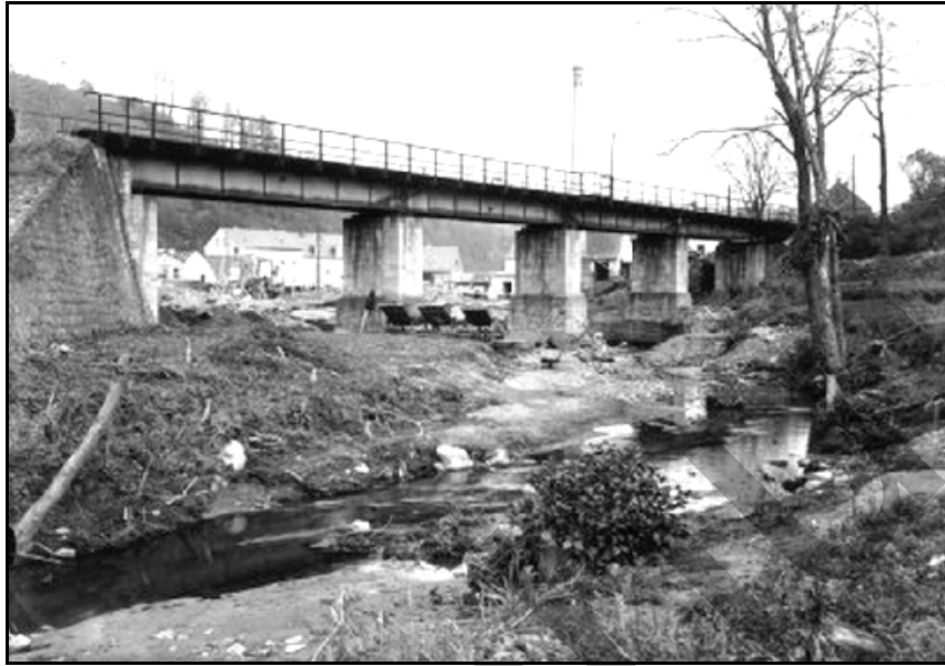
Abb. 5.1.33: Die Ursache der hohen Flutwelle: Die Eisenbahnbrücke. Hinter ihr staute das mitgerissene Holz einen See an, der dann durchbrach.
