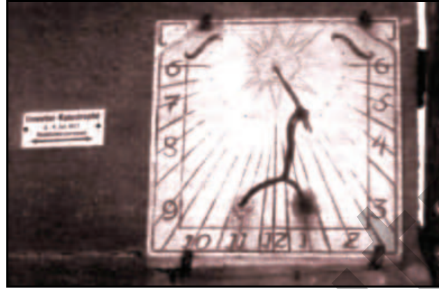
Abb. 5.14.22: Sonnenuhr und Hochwassermarke an der Zwieselmühle 1985.
