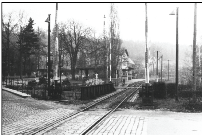
Abb. 5.1.12: Die Brücke über die Gottleuba nach dem Bahnhof Berggießhübel 1960.
