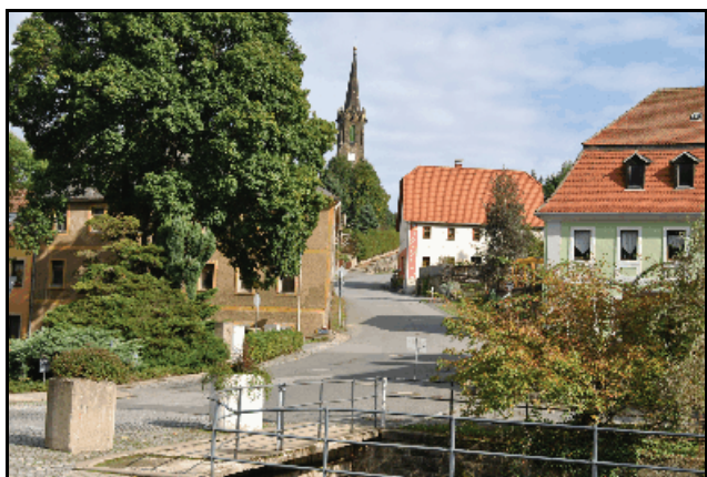
Abb. 5.1.115: Zustand der Brücke 2010.
