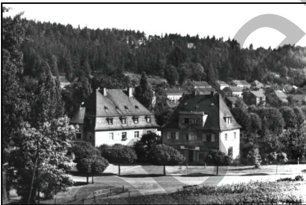
Abb. 5.10.16: Blick vom Kaffeeberg um 1936. Das linke Gebäude ist die 2. Marienapotheke Talstr. 1.
