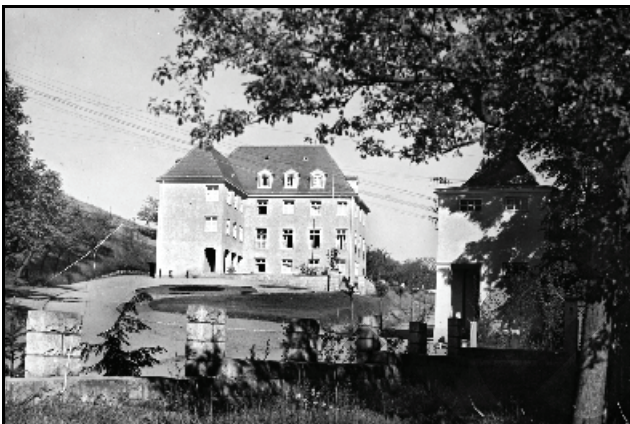
Abb. 5.2.10: Das fertige Haus Talfrieden 1936.
