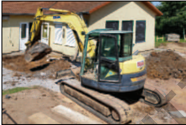
Abb. 5.4.16: Der Bau der Kindertagesstätte 1997.
