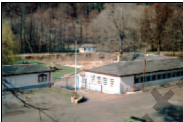
Abb. 5.8.6: Abriss 1994. Foto: Klaus Seeger, Bergg.
