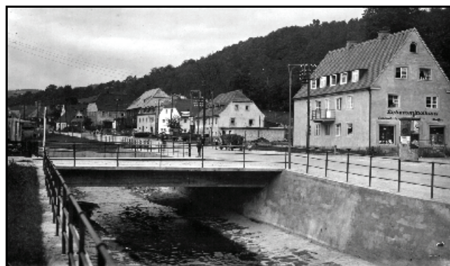
Abb. 5.1.114: Die 1928 errichtete Brücke am Kirchberg um 1935.
