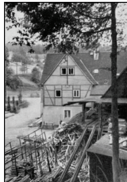
Abb. 5.14.20: Blick auf das Sägewerk 1960.
