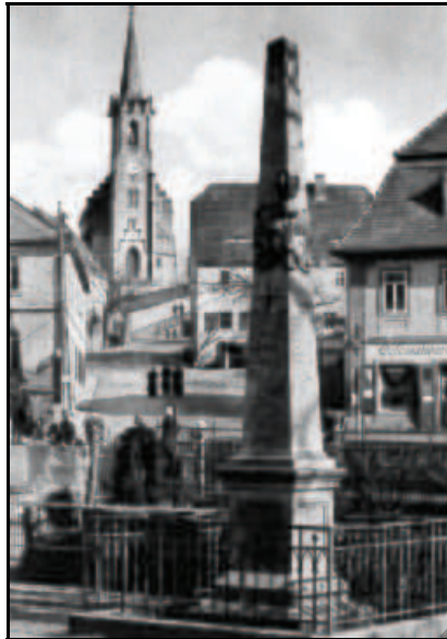
Abb. 5.7.3: Blick in Richtung Kirchberg mit der umgesetzten Postdistanzsäule 1920.
