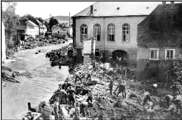
Abb. 5.1.43: Blick in die Giesensteiner Straße in Richtung Gottleuba. In der Mitte der Stern.
