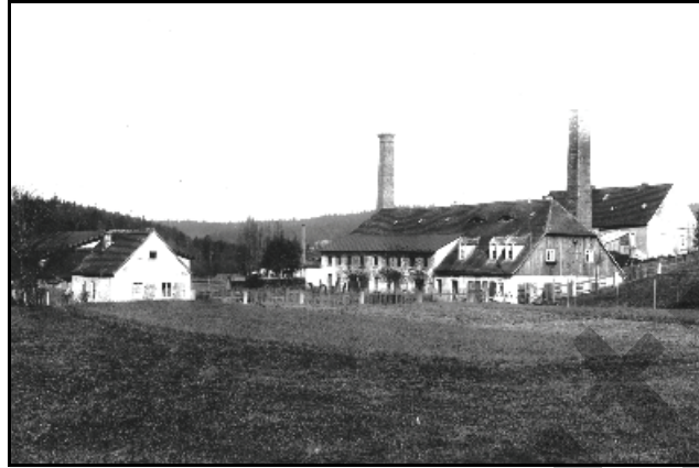
Abb. 5.13.3: Der alte Oberhammer von 1850, der 1911 stillgelegt wurde. Das Hammermeisterhaus und das darüber liegende Gebäude stehen noch.
