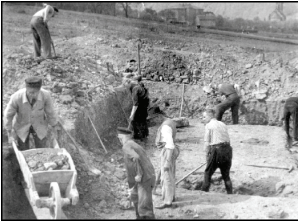
Abb. 5.1.88: Bau der Siedlung am Kaffeeberg 1974.
