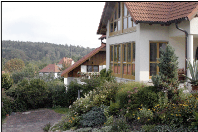
Abb. 5.1.94: Die neuen Einfamilienhäuser auf dem Kaffeeberg 2005
