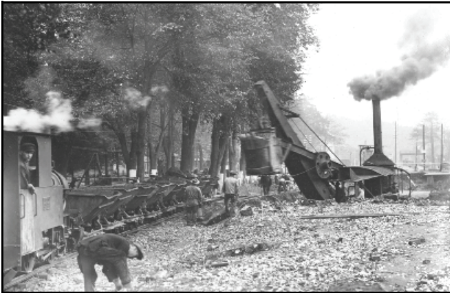
Abb. 5.1.49: Ausheben des neuen Bachbettes vor dem Bahnhof (in der Nähe der jetzigen Bushaltestelle).
