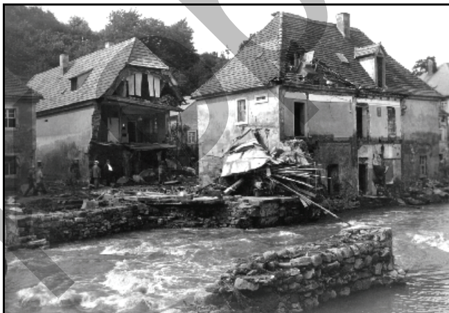
Abb. 5.1.47: Blick auf die Giesensteiner Straße.
