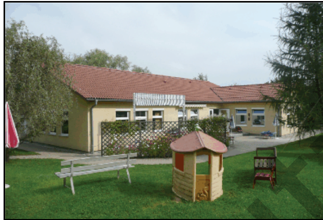
Abb. 5.4.22: Der fertige Anbau 2019.
