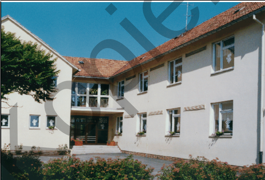
Abb. 5.4.8: Die 1968 erbaute 3. Schule auf der Siedlung. Foto: Schule
