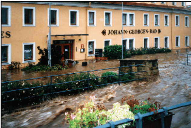
Abb. 5.1.102: Hochwasser am 13. August 2002 am Johann-Georgen-Bad.
