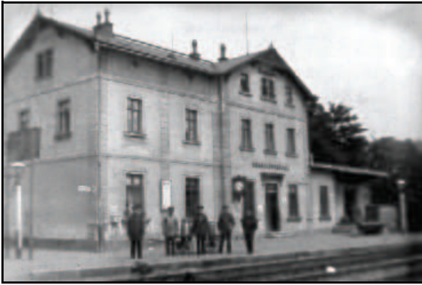
Abb. 5.1.10: Bahnhof Berggießhübel um 1920.
