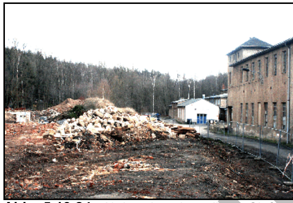
Abb. 5.13.24: Abriss der ehemaligen Gießerei 2015.
