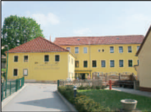
Abb. 5.10.29: Das ehemalige Scheidehaus als Museum und Verwaltungsgebäude 2008.
