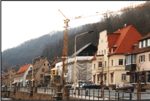
Abb. 5.10.7: Umbau des "Goldenen Sterns" Giesensteiner Str. 8 im Jahre 2000. Foto: K. Seeger
