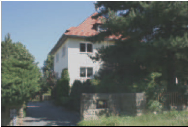
Abb. 5.4.15: "Rauchfuß-Villa" als Kindergarten 2007.
