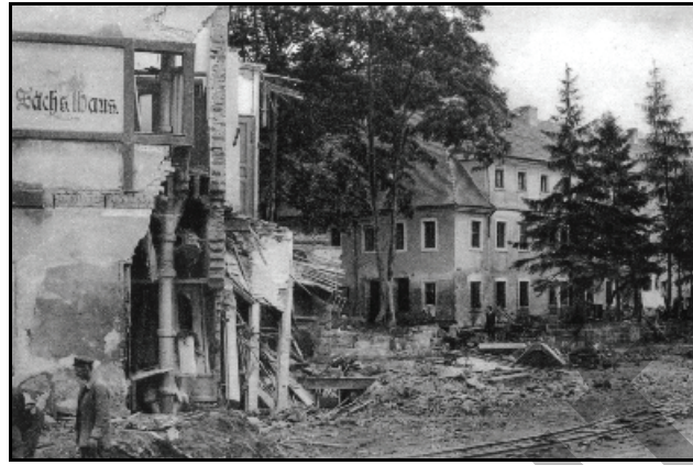
Abb. 5.1.44: Das "Johann-Georgen-Bad" nach dem Hochwasser. Links das "Sächsische Haus".
