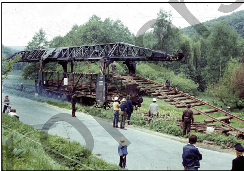
Abb. 5.1.19: Rückbau der Gleise zwischen Bad Gottleuba und Berggießhübel 1976. Foto: Samml. Möritz, Berggießhübel
