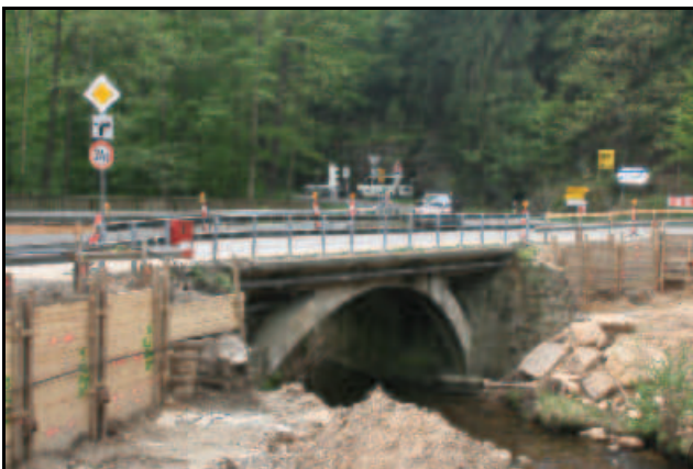
Abb. 5.14.13: Beginn der Arbeiten zum Ersetzen der alten Zwieselbrücke (Blick stromauf).
