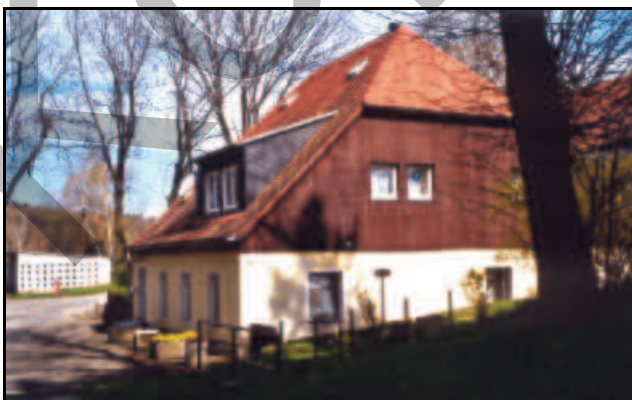
Abb. 5.12.8: Das Meisterhaus Am Oberhammer 1 des ehemaligen Oberhammers 2001.
