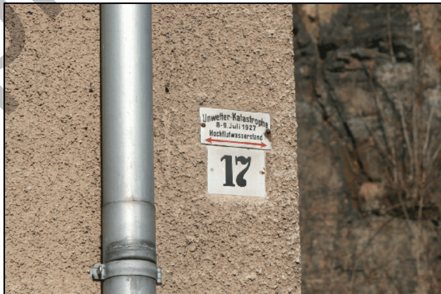
Abb. 5.1.31: Die Hochwassermarke von 1927 neben Fallrohr.
