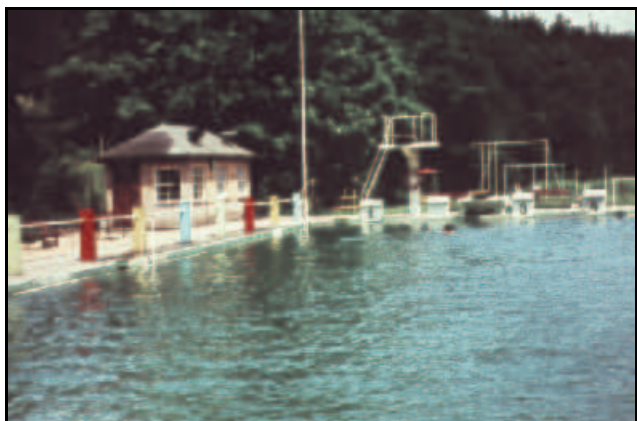
Abb. 5.8.5: Das Freibad vor der Rekonstruktion.
