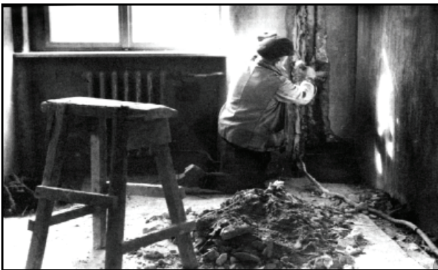
Abb. 5.2.14: Umbau des Schlosses „Friedrichsthal“ .
