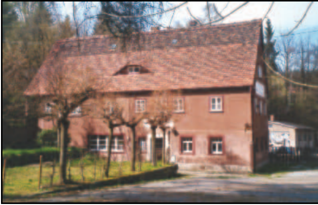
Abb. 5.14.21: Die Zwieselmühle i. J. 2001. Rechts der Schaden durch den Diebstahl der Sonnenuhr.
