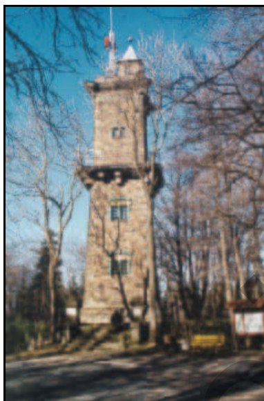
Abb. 5.10.26: Der am 5.5. 1990 wiedereröffnete Bismarckturm.
