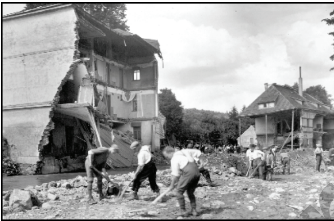
Abb. 5.1.40: Links die Post dahinter das alte Sächsische Haus, die nach dem Hochwasser abgerissen werden mussten.
