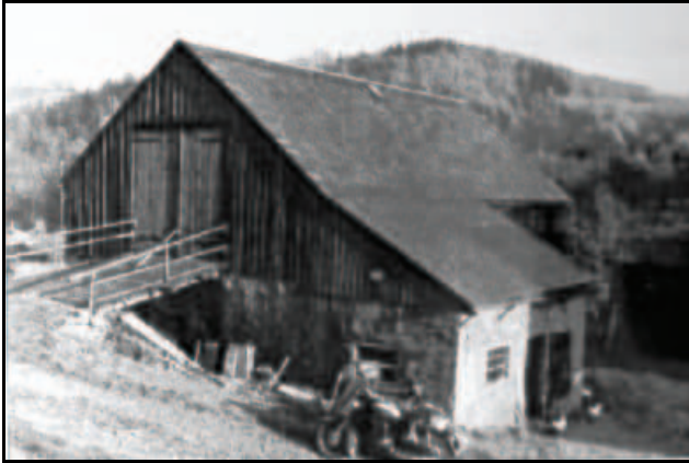
Abb. 7.3.46: Zur Meiselmühle gehörende Scheune. Abb. nach [7.9].
