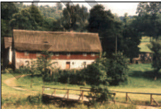
Abb. 7.3.38: Gut Richard Kühnel mit der Holzbrücke um 1950. Abb. Archiv Oelsen.
