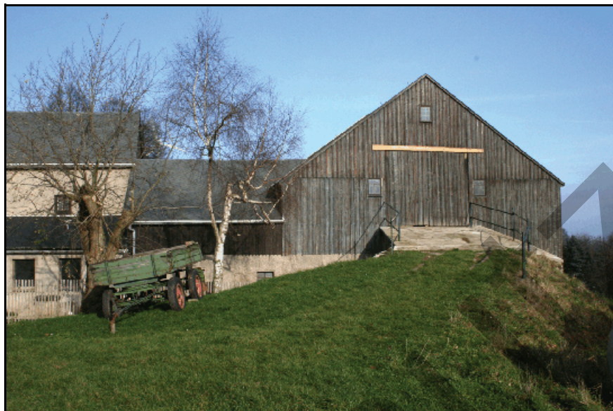
Abb. 7.1.46: Die Hocheinfahrt vom Feld aus.
