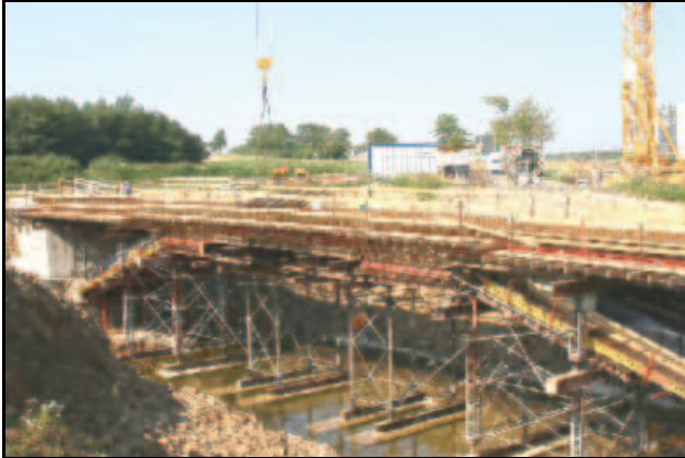
Abb. 7.1.82: Bau der Brücke über die Autobahn für die Staatsstraße 174 2004.
