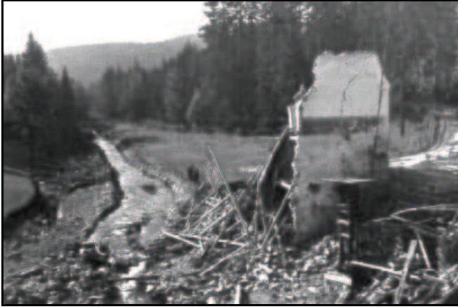
Abb. 7.3.52: Die durch das Hochwasser 1927 zerstörte Mühle. Landesverein Sächs. Heimatschutz [7.13].
