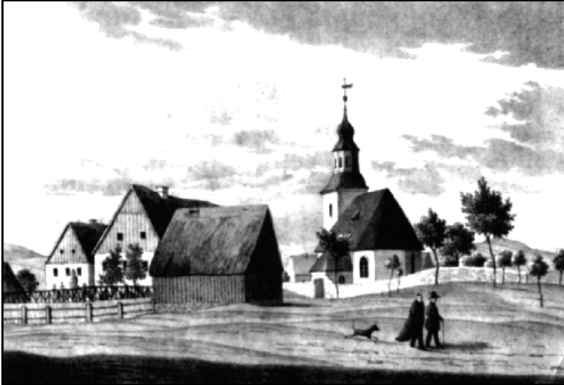
Abb. 7.1.21: Die 1817 wieder aufgebaute Kirche und Pfarre von Breitenau um 1840. Links die 1827 erbaute Schule und davor die Scheune, die Napoleon bei seiner Übernachtung 1813 als Pferdestall nutzte. Die Gebäude haben noch ein Strohdach. Abb. nach [7.24].
