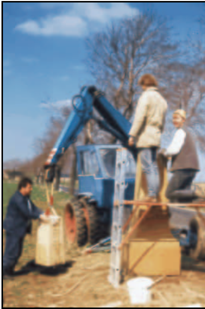
Abb. 7.1.6: Aufstellen der Säule 1994. Foto: M. Kajer, Bergg.
