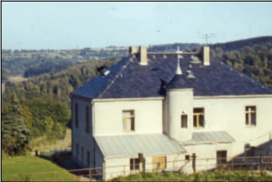
Abb. 7.3.58: Die 1906 erbaute Horn-Villa, das spätere Forsthaus im Jahre 2008 als Wohnhaus.
