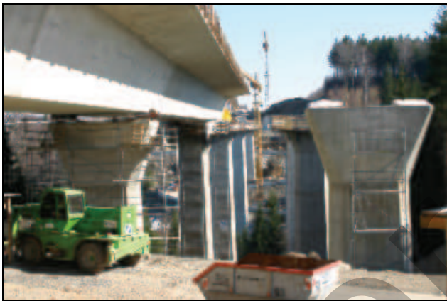
Abb. 7.1.90: Das Schieben der vorgefertigten Fahrbahn auf die Pfeiler von der Breitenauer Seite aus 2005.
