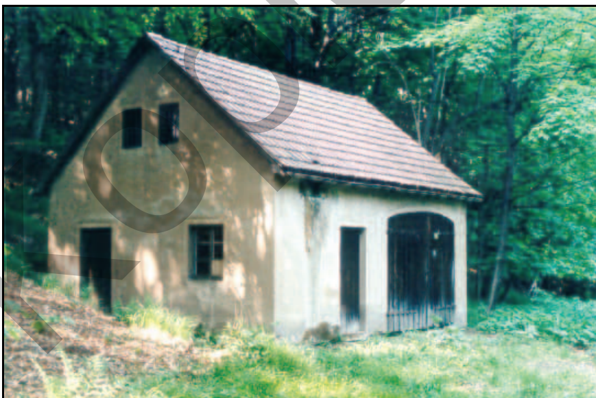
Abb. 7.3.83: Das Gebäude der ehemaligen Feuerwehr Oelsengrund Nr. 10 im Jahre 2002, als einzig stehen gebliebenes Haus im Ort.
