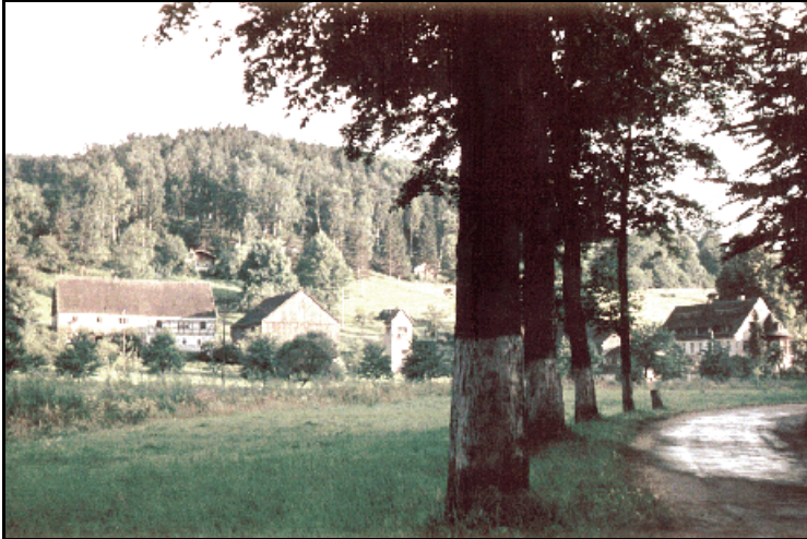
Abb. 7.3.23: Häbigs Gut Nr. 2 um 1950, rechts die Scheune und dann das Trafohaus. Foto: Bernd Kadner Dresden.
