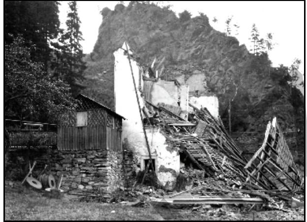
Abb. 7.3.53: Die durch das Hochwasser 1927 zerstörte Mühle.
