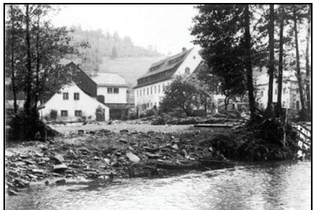
Abb. 7.3.12: Das Hammergut nach dem Hochwasser 1927.
