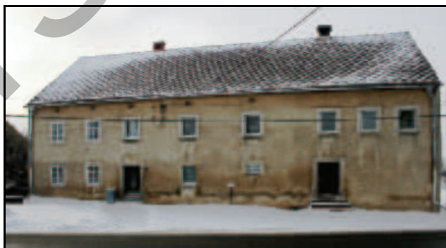
Abb. 7.1.71: Das Haus Nr. 11 im Jahre 2014. Die Inschrift über dem Eingang lautet; "G. Böhme/erbaut 1888".
