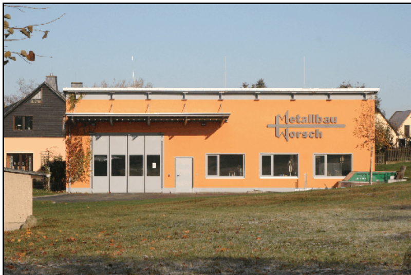
Abb. 7.1.77: Der Metallbaubetrieb Worsch Breitenau Nr. 51 2008.
