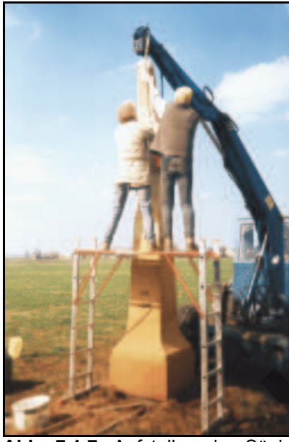
Abb. 7.1.7: Aufstellen der Säule 1994. Foto: M. Kajer, Bergg.
