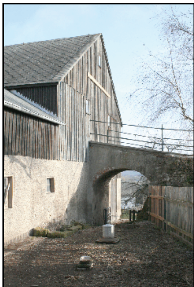
Abb. 7.1.45: Die Hocheinfahrt an der Scheune.
