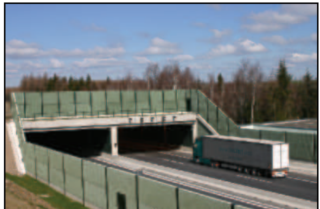
Abb. 7.1.93: Der fertige Landschaftstunnel 2006.
