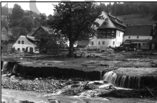
Abb. 7.3.11: Das ehem. Hammergut (in der Mitte das Haus von Stötzner) nach dem Hochwasser 1927. Foto: Landesverein Sächs. Heimatschutz.
