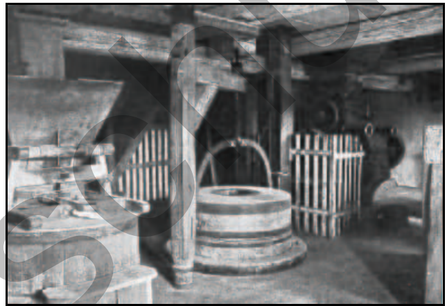
Abb. 7.2.5: Mahlstube der Mühle Walddörfchen 1929. Links die Mühle mit dem Trichter, in der Mitte der Mühlsteingalgen, rechts der Walzenstuhl. Foto nach [7.23].
