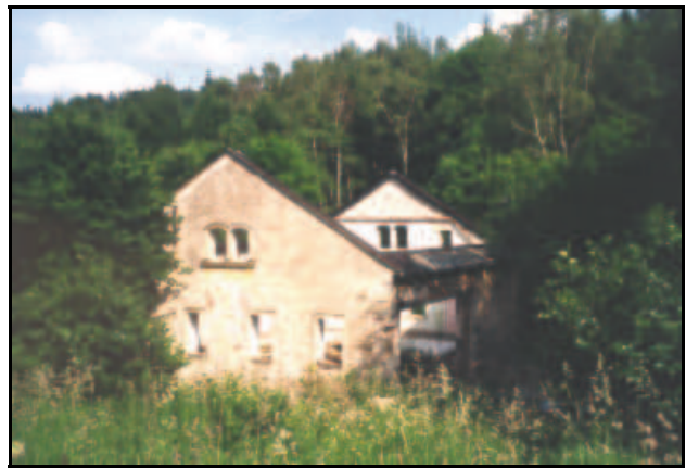
Abb. 7.3.51: Die Ruine der Meiselmühle 2001
