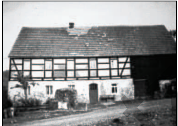
Abb. 7.3.35: Das Martin-Haus Nr.4. Am Dach der Schaden durch die teilweise umgestürzte Linde. Die Linde musste gefällt werden. Abb. nach [7.9].
