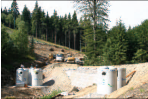
Abb. 7.1.88: Die Klär- und Absetzbehälter unterhalb der Brückenbaustelle 2004.
