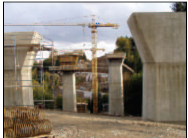
Abb. 7.1.87: Das Errichten der Brückenpfeiler 2004. Blick von der Breitenauer Seite.
