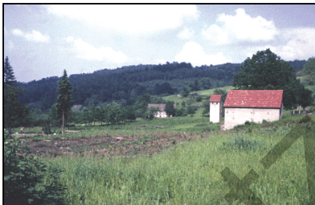
Abb. 7.3.20: Es steht nur noch das Transformatorenhaus und die Scheune des Hammergutes. Im Hintergrund das Haus Martin. Bernd Kadner, Dresden.
