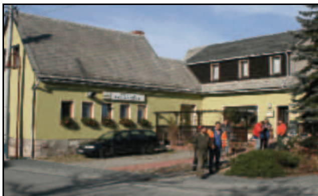
Abb. 7.1.68: Die Bauernstube Breitenau Nr. 36 von Jörg Hanzsch. Vorher befand sich hier der Konsum.
