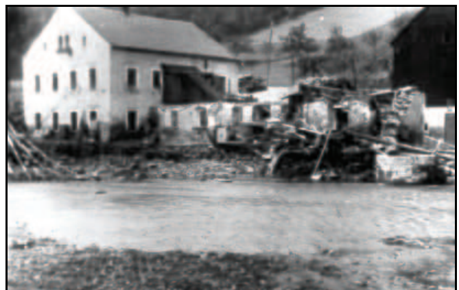
Abb. 7.3.45: Die Meiselmühle nach dem Hochwasser 1927.
