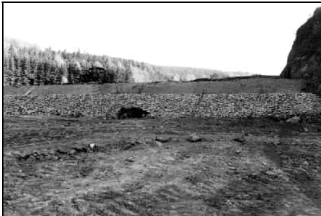
Abb. 8.1.52: Schüttarbeiten am Damm. Foto: Archiv Markersbach.
