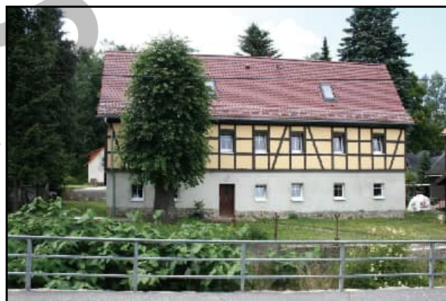
Abb. 8.1.64: Das ehemalige Ferienheim als Wohnhaus Grenzlandstr. 32.
