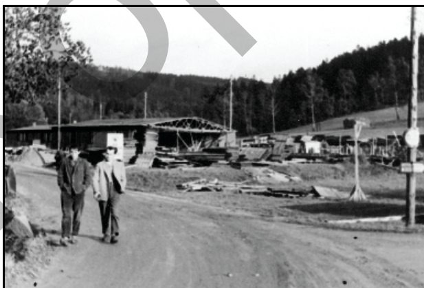
Abb. 8.1.42: Bau der Baubaracken 1958 gegenüber der "Ultra". Foto: Archiv Markersbach
