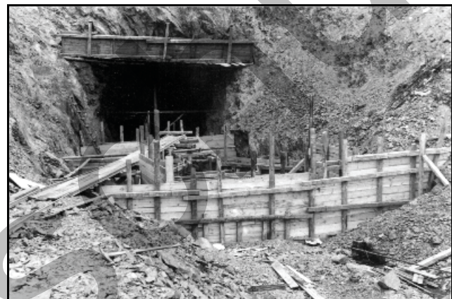
Abb. 8.1.47: Der Eingang des Umlaufstollens im Bau. Foto: Archiv Markersbach
