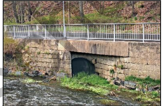
Abb. 8.2.13: Austritt des Mühlgrabens in die Bahra.
