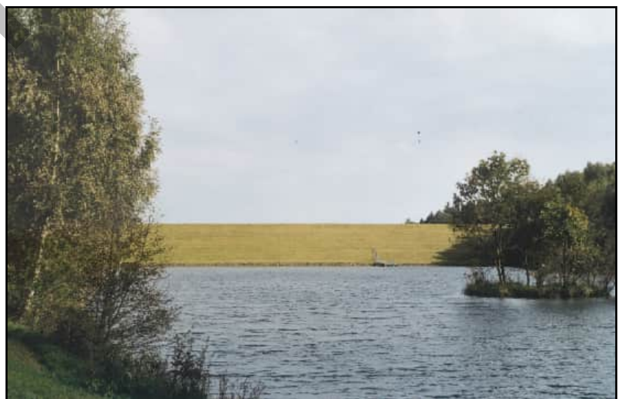
Abb. 8.9.23: Das idyllisch gelegene Rückhaltebecken im Mordgrund.
