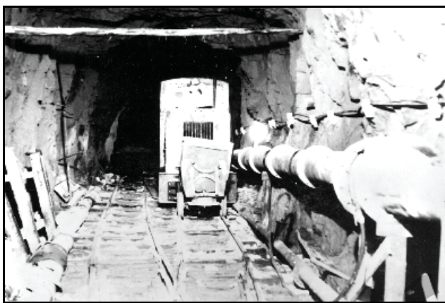
Abb. 8.1.46: Arbeiten am 132 m langen und 3,7 m breiten Umlaufstollen. Foto: Archiv Markersbach.
