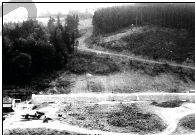
Abb. 8.1.58: Der Bereich unter dem späteren Damm mit dem Grundablass um 1962.
