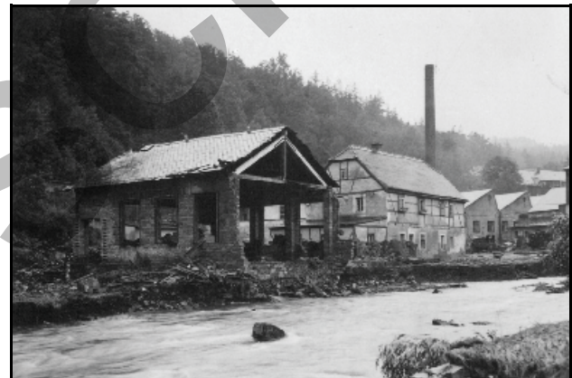
Abb. 8.2.31: Das Hammergut Kleppisch nach dem Hochwasser 1957.
