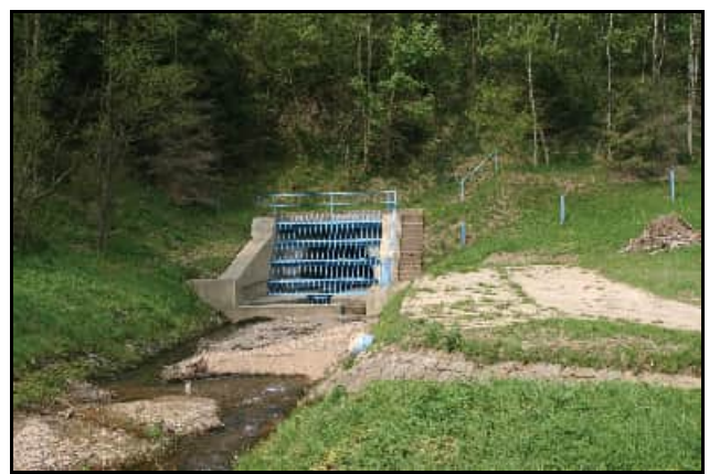
Abb. 8.1.55: Das Gitter für den Umlaufstollen im Jahre 2012.
