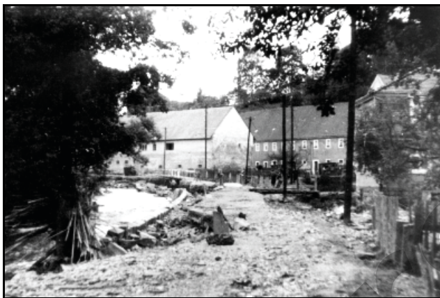
Abb. 8.1.35: Blick flussauf in Cratza beim Hochwasser 1957. Samml. Gottfried Kretzschmar, Hellendorf.
