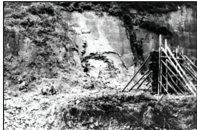
Abb. 8.1.45: Der Felsen am Eingang des Umlaufstollens. Foto: Archiv Markersbach.
