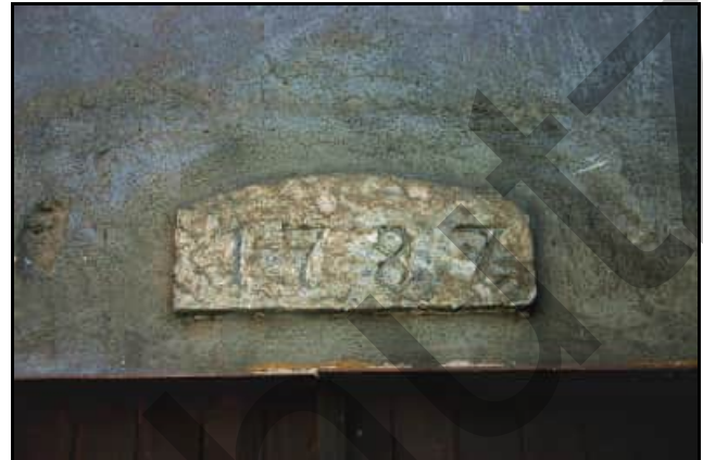
Abb. 8.2.7: Die Jahreszahl 1787 an einem Gebäude des Hammergutes Cratza 2007.
