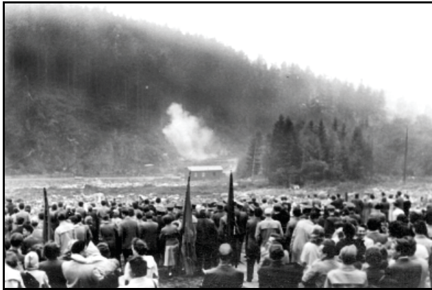
Abb. 8.1.44: Die 1. Sprengung am Stollen. Foto: Archiv Markersbach
