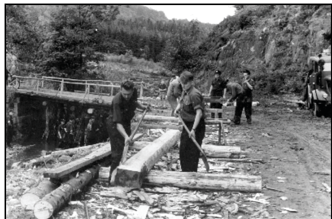
Abb. 8.1.43: Bau der Brücke für die schwere Technik 1958. Foto: Archiv Markersbach
