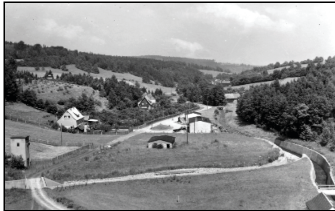
Abb. 8.1.60: Blick vom Damm auf Bärhau um 1968. Links der Überlauf und rechts der Grundablass. Foto: Archiv Markersbach
