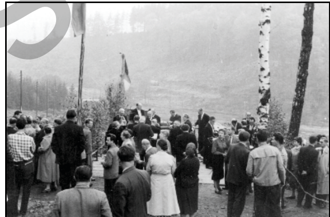
Abb. 8.1.41: Feier aus Anlass des Ersten Spatenstiches. Foto: Archiv Markersbach
