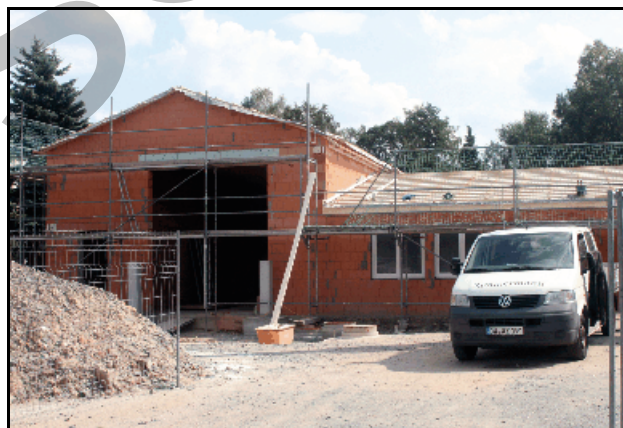
Abb. 8.6.12: Der Bauzustand im September 2019.
