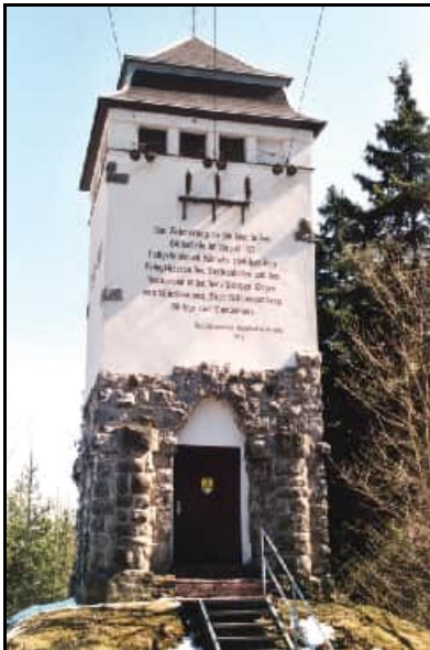
Abb. 8.1.7: Die Trafostation auf dem Augustusberg an der Hellendorfer Straße.
