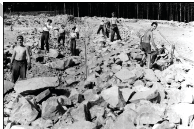
Abb. 8.1.49: Beginn der Arbeiten am Damm 1958.
