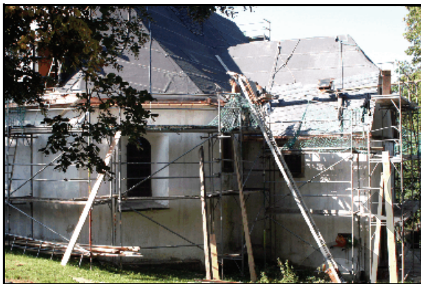
Abb. 11.1.125: Dachdecker bei der Arbeit 2011.
