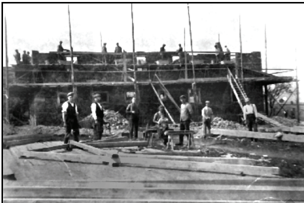
Abb. 11.1.52: Neubau des Wohnhauses 1924. Foto: Frau Pilz, Oelsen.
