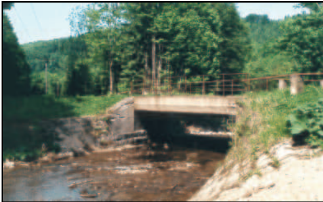
Abb. 11.4.21: Die alte Gottleubabrücke beim ehemaligen Dorf Oelsengrund 2006.
