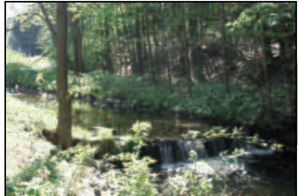
Abb. 11.4.22: Die Reste des alten Wehres der Clemensmühle 2009.
