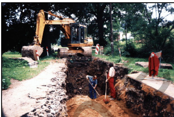
Abb. 11.1.22: Bau der Abwasserleitung 1993. Foto: Archiv Oelsen.
