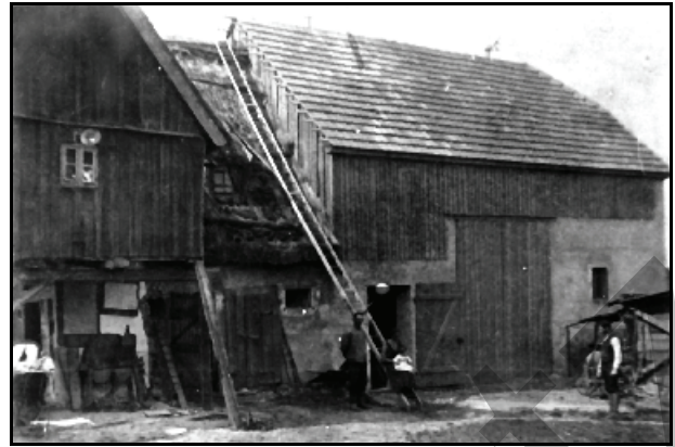
Abb. 11.1.51: Links das Wohnstallhaus, rechts die Scheune im Jahre 1927. Foto: Frau Pilz Oelsen.
