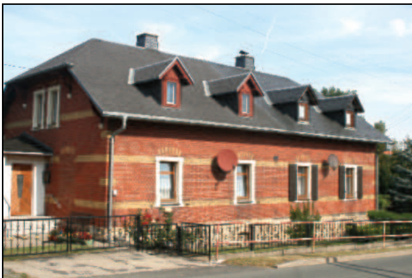
Abb. 11.1.8: Das ehemalige alte Grenzerhaus Nr. 30b in Oelsen.
