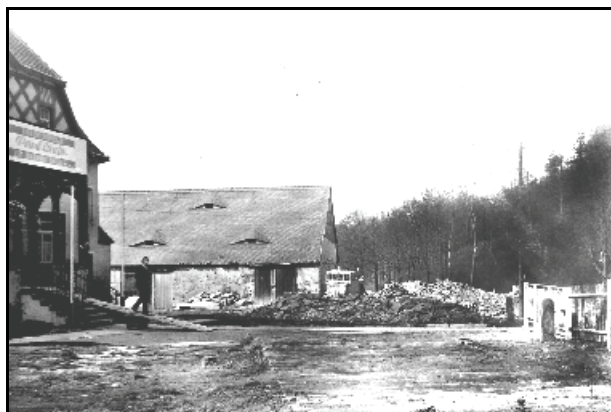
Abb. 11.2.20: Abriss des Zechelhauses 1974. Foto: Archiv Oelsen.
