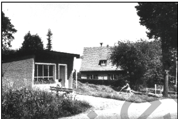
Abb. 11.1.16: Das 1962 erbaute Buswartehäuschen am Gemeindeamt. Foto: Archiv Oelsen.
