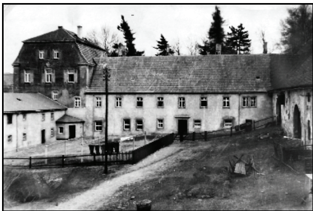
Abb. 11.1.84: Blick auf das ehemalige Rittergut Oelsen um 1930. Links die Villa, davor der Anbau, rechts daneben das Haus der Herrschaft und dann die Ställe und Scheunen. Foto: Archiv Oelsen.
