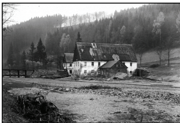
Abb. 11.1.5: Die Paustmühle nach dem Hochwasser 1927 mit Behelfsbrücke über die Gottleuba.
