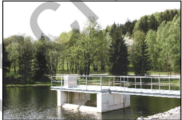
Abb. 11.1.29: Blick auf das Vorbecken am Oelsenbach 2009.
