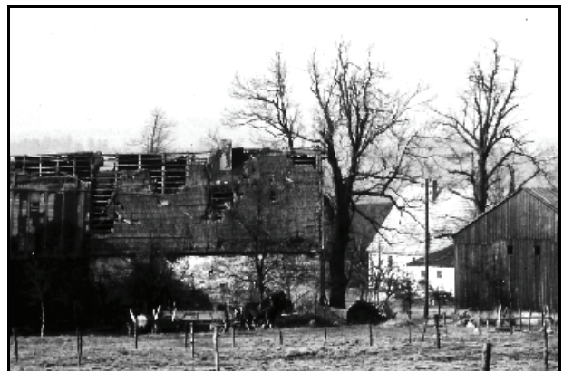
Abb. 11.1.49: Das bereits verfallende Haus Nr. 48. Nach dem Abriss kein Neubau. Foto: Archiv Oelsen.
