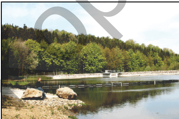
Abb. 11.4.23: Das Vorbecken am Oelsenbache.
