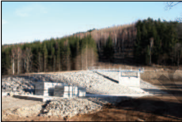
Abb. 11.1.28: Bau des Vorbeckens am Oelsenbach 2008.
