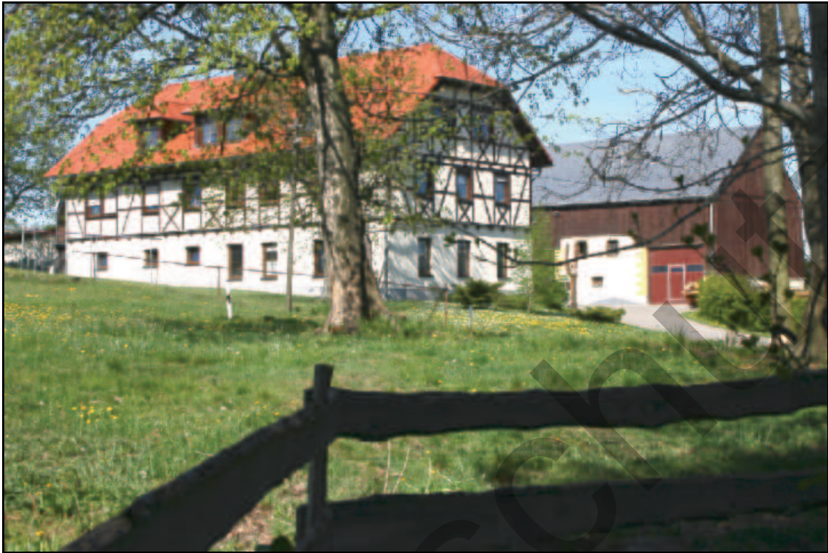
Abb. 11.1.58: Das Fachwerkwohnhaus im Gut Nr.38.
